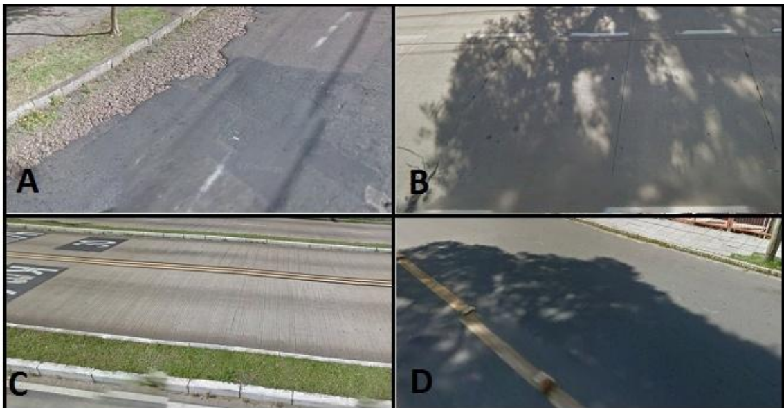
Figura 3.5 - Pavimento rústico (A); Placas moldadas de concreto antigas (B); Placas de concreto moldado novas (C); Asfalto (D).
