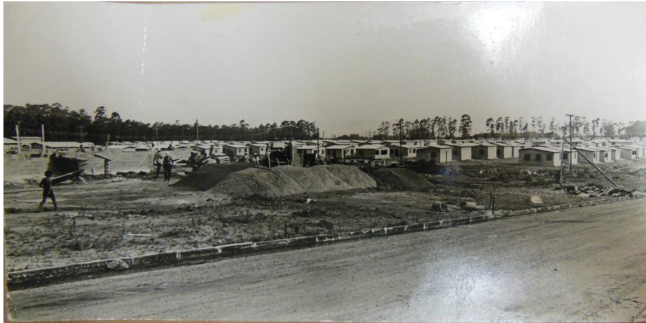
Fotografia 2 – Construção de casas do Conjunto Habitacional Ildo Meneghetti
