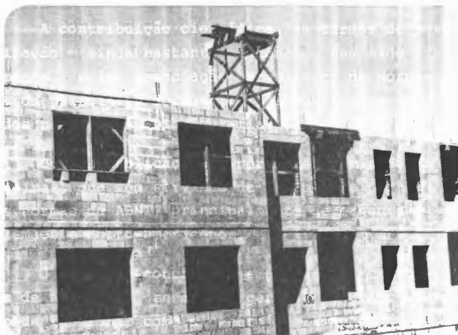
**FIGURA 9** - Edificação com uso de alvenaria de blocos de concreto
