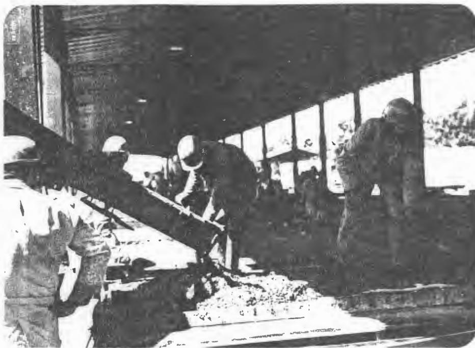
**FIGURA 20** - Fabricação de componentes de fachada de um sistema construtivo pré-fabricado de concreto
