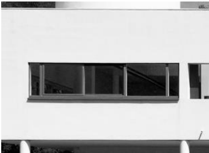
fig. 6.17. Le Corbusier: Villa Savoye - ventana horizontal
