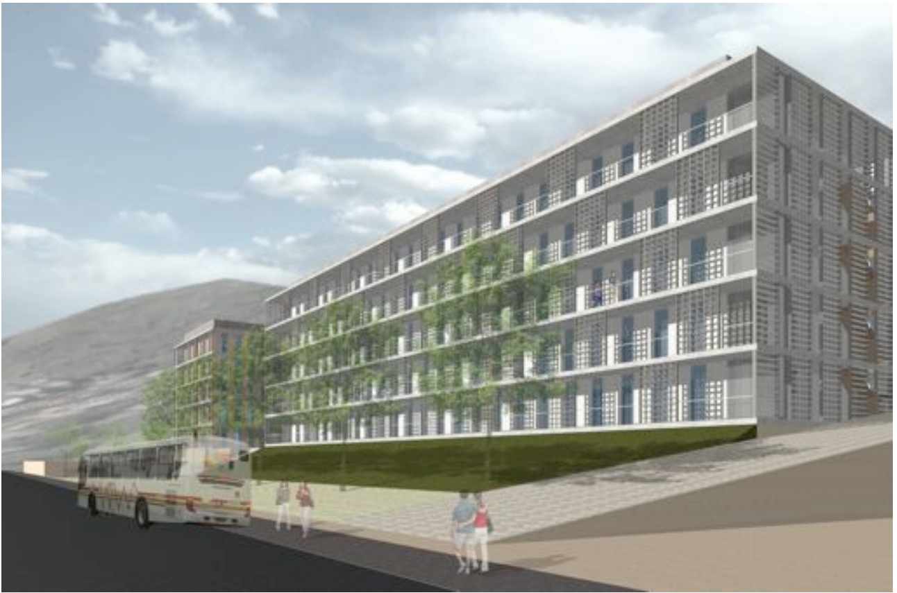
Figura 24. Vista do conjunto desde a avenida de acesso.
