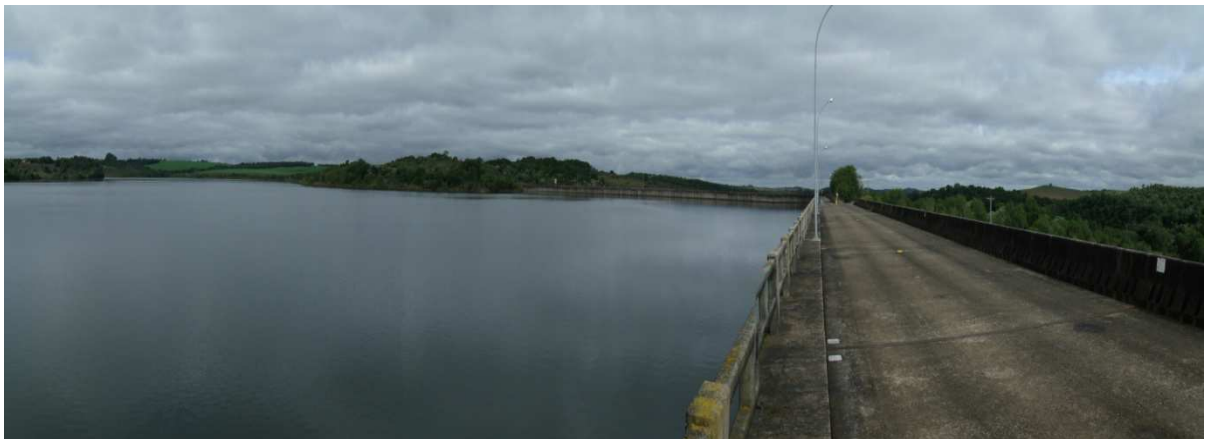
Figura 5-4 – Vista da baragem, lago e áreas circundantes.
