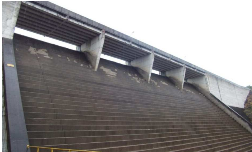
Figura 5-5 – Barragem e vertedouro.
