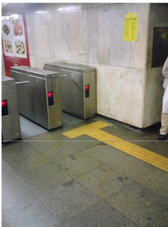
Figura 8 - Piso Podo tátil Direcional Amarelo 25 x 25 cm, ao longo de acesso a roleta, tendo antes da roleta Piso Podo tátil Alerta Amarelo 25 x 25 cm
