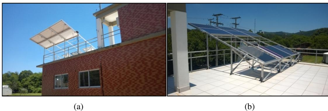
Figura 4.6 – Fotografia da estrutura montada e módulos fotovoltaicos instalados: (a) vista de fora do prédio anexo do LABSOL; (b) vista em cima do terraço do prédio.
