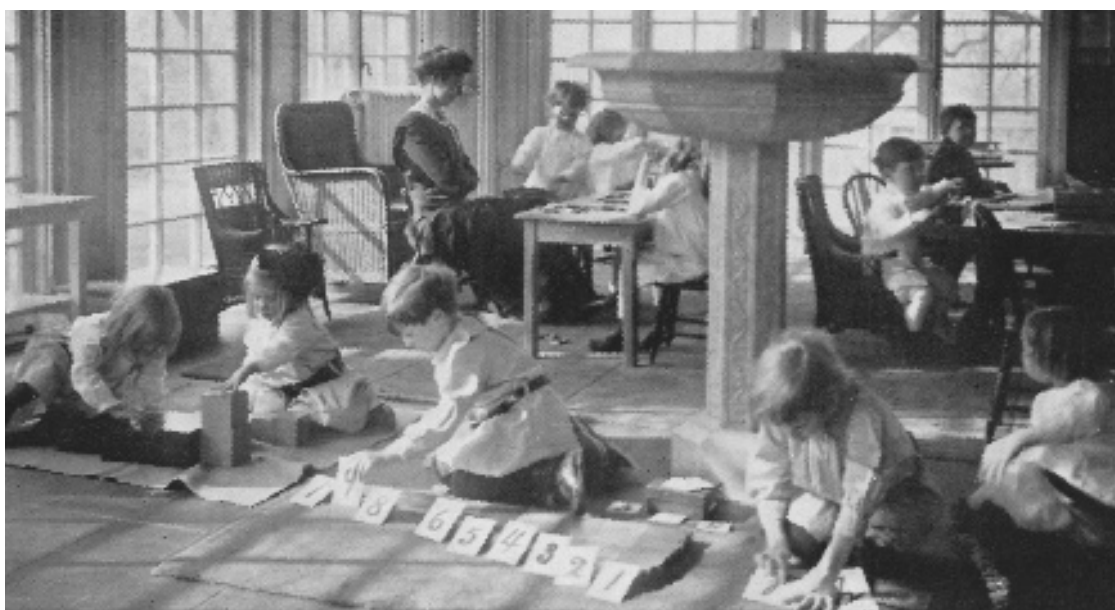
Figura 20. Sala de aula montessoriana
