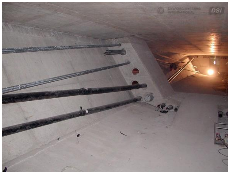
Figura 1.3 – Disposição dos cabos de protensão ( http://en.structurae.de/products/data/index.cfm?ID=25 ).
