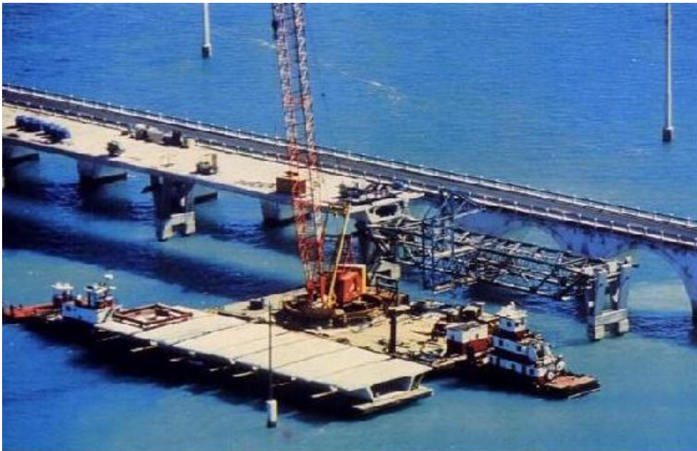
Figura 2.23 – Ponte Long Key (Association pour la mémoire et le rayonnement des travaux d'Eugène Freyssinet, 2004)
