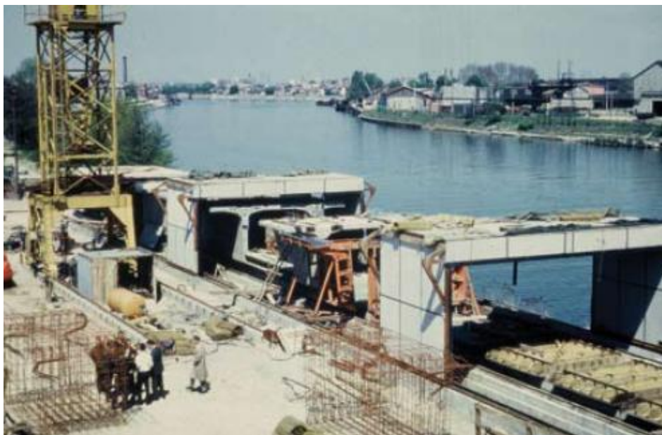
Figura 2.3 - Pista de concretagem da ponte Choisy-le-Roi (Tassin, 2006).
