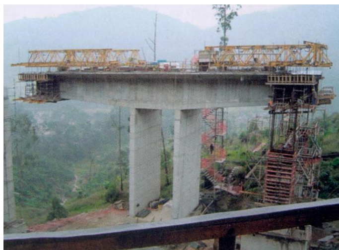
Figura 2.19 – Viaduto na Rodovia Mogi-Dutra
