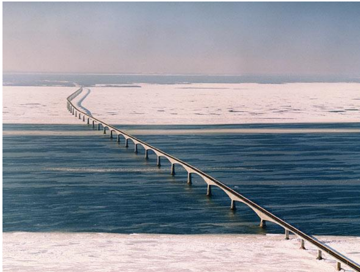
Figura 2.7 - Ponte da Confederação (Canadá) ( www.confederationbridge.com )
