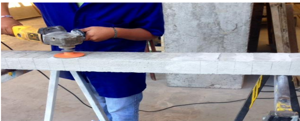
Figura 4 – Lixação do concreto
