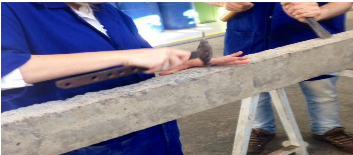
Figura 3 – Apicoamento do concreto
