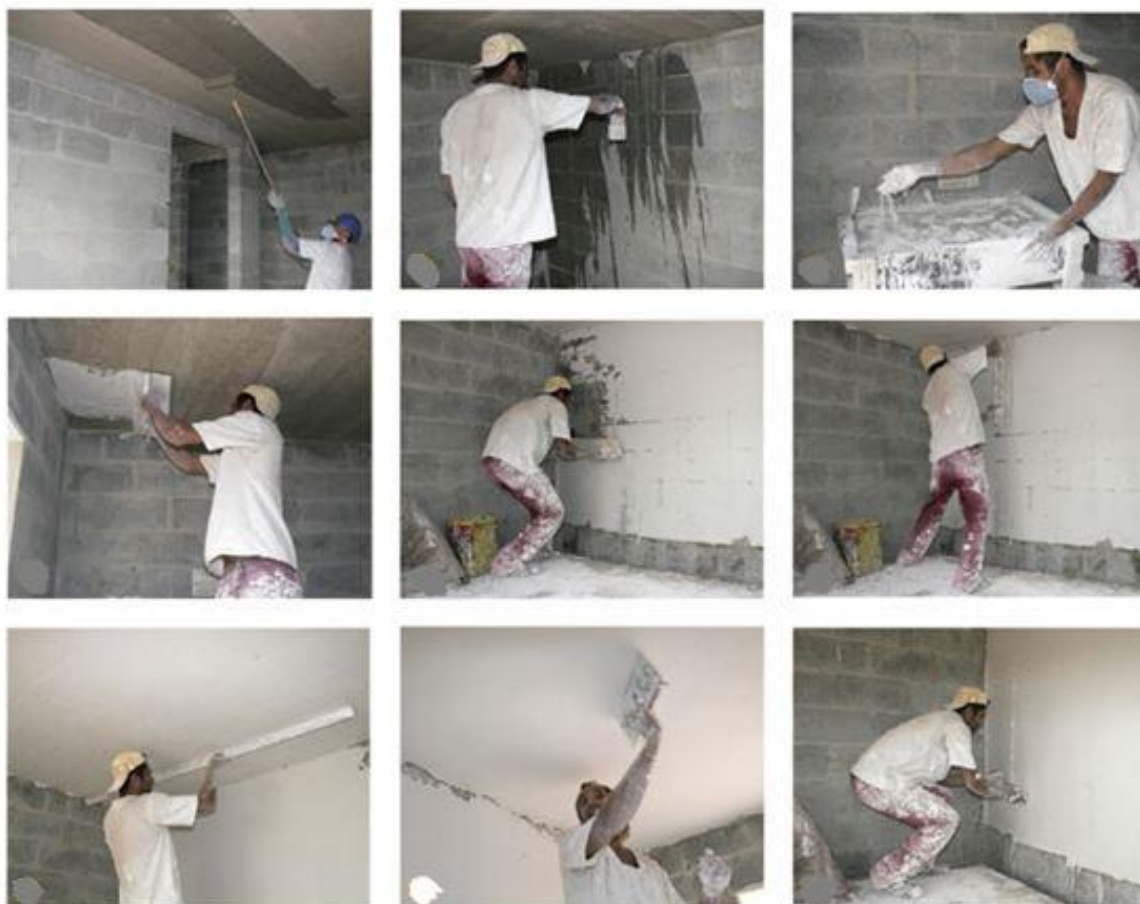
Figura 3 – Processo de execução do revestimento desempenado
