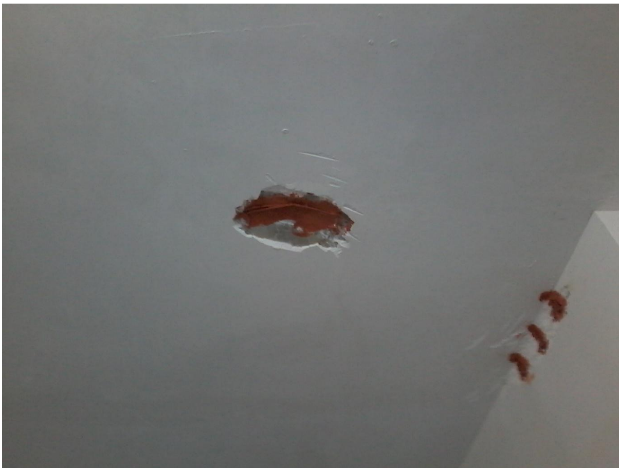
Figura 25 – Aplicação de zarcão nos pontos metálicos
