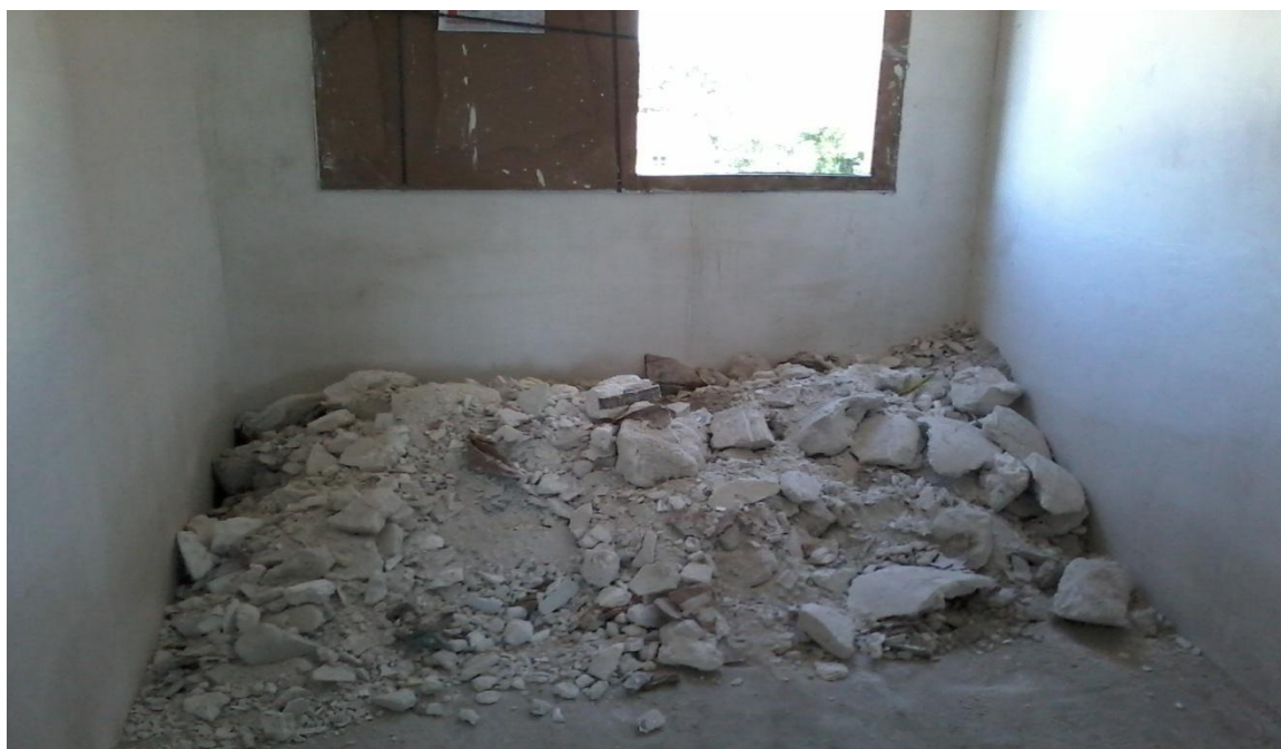
Figura 4 – Quantidade resíduos gerados na aplicação do revestimento de pasta de gesso
