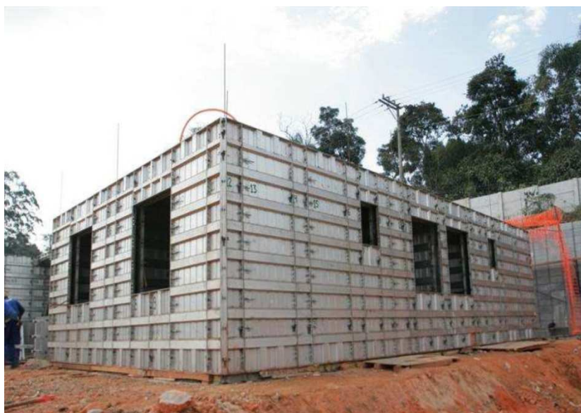
Figura14 – Sistema de fôrmas de alumínio
