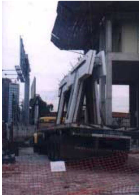
Figura8 – Transporte de elementos pré-fabricados feito por meio rodoviário
