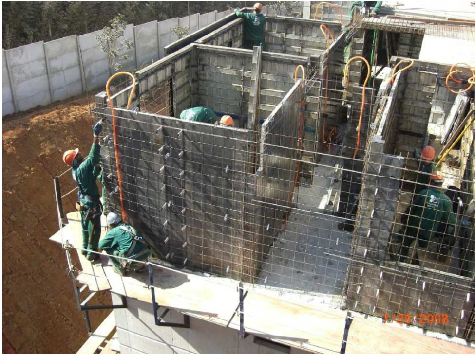
Figura23 – Atividades manuais caracterizam o sistema de moldagem in loco
