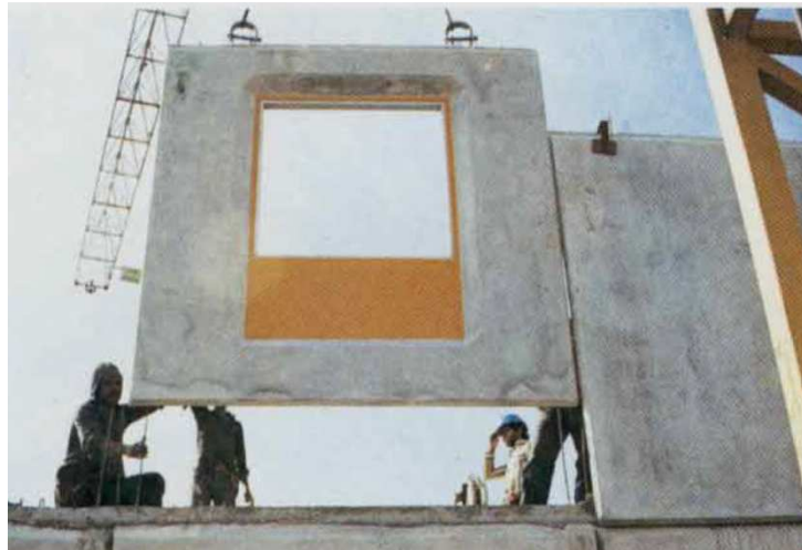
Figura24 – Montagem de parede de concreto pré-moldada com grua
