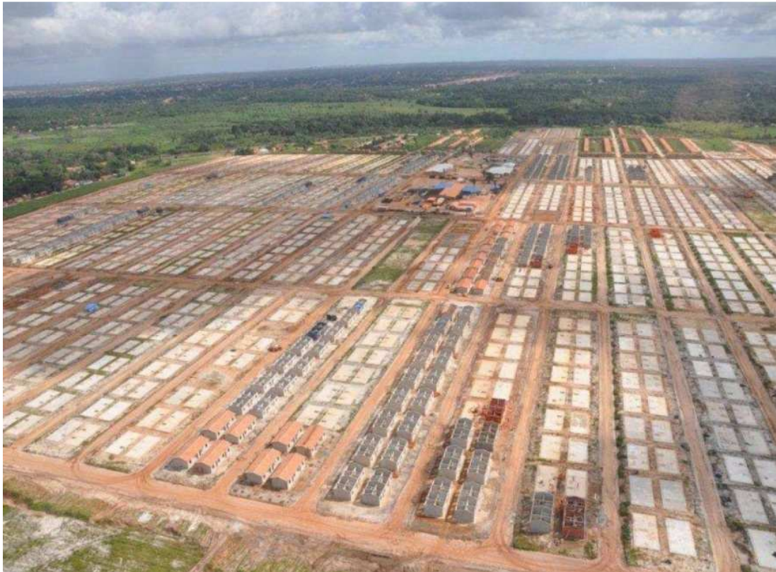
Figura3 – Canteiro de obras de conjunto habitacional
