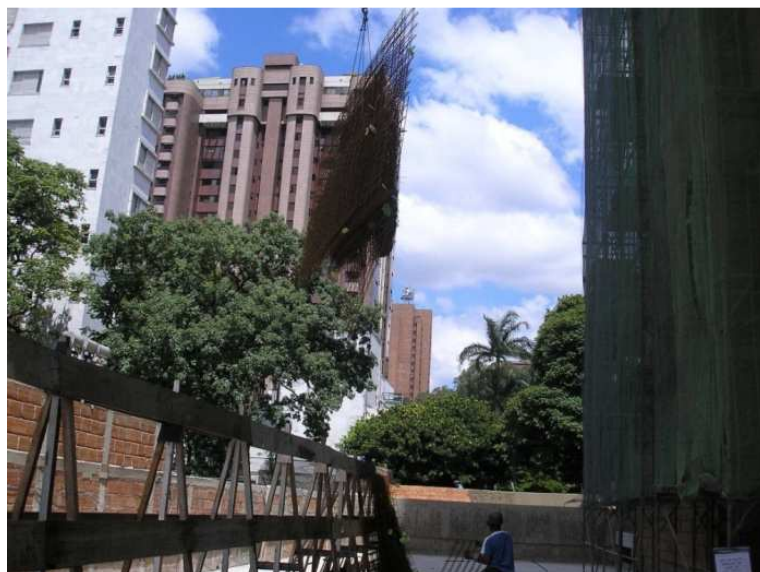
Figura4 – Transporte interno de insumos: malha de aço
