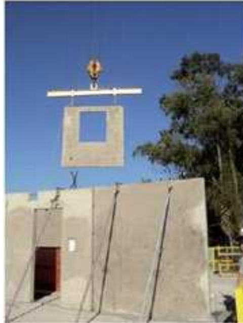
Figura11 – Montagem com grua
