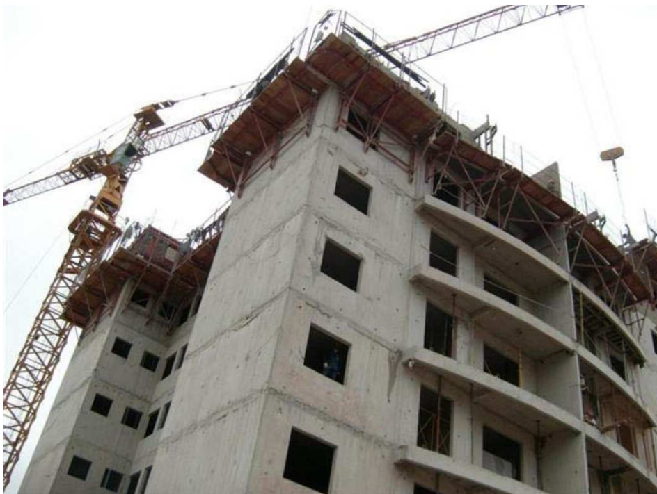
Figura2 – Paredes de concreto
