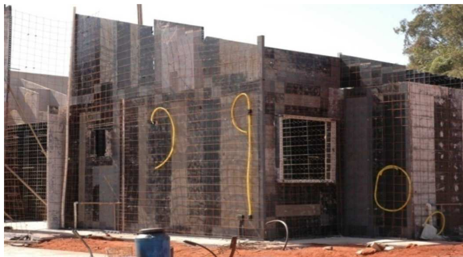
Figura16 – Instalações elétricas e caixilhos
