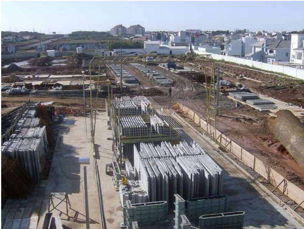
Figura21 – Canteiro com pré-moldados organizados
