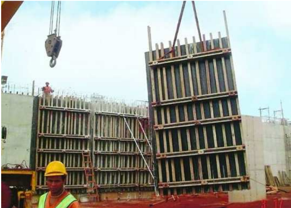
Figura 22 – Fôrmas de grandes dimensões movimentadas com guindaste
