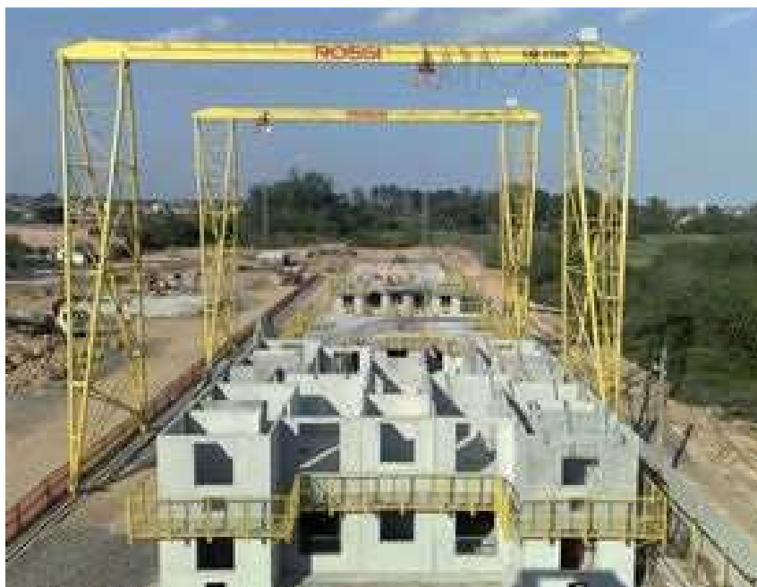
Figura5 – Paredes de concreto pré-moldadas
