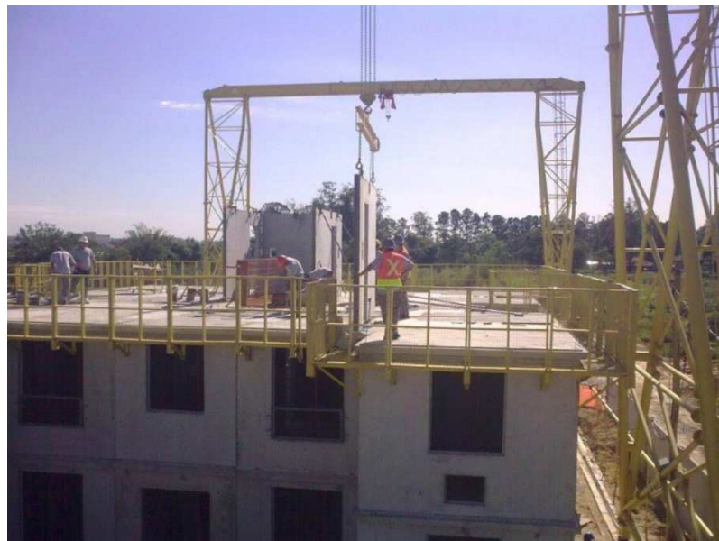
Figura12 – Montagem com pórtico rolante
