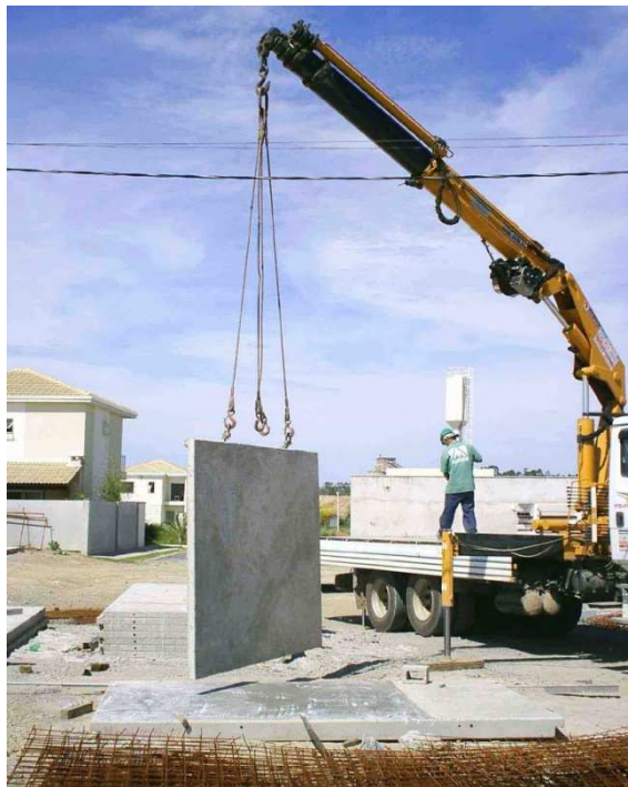
Figura10 – Descarga de elementos pré-fabricados
