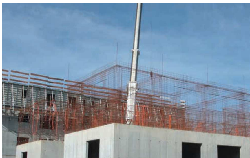
Figura15 – Armaduras e sistemas complementares fixados
