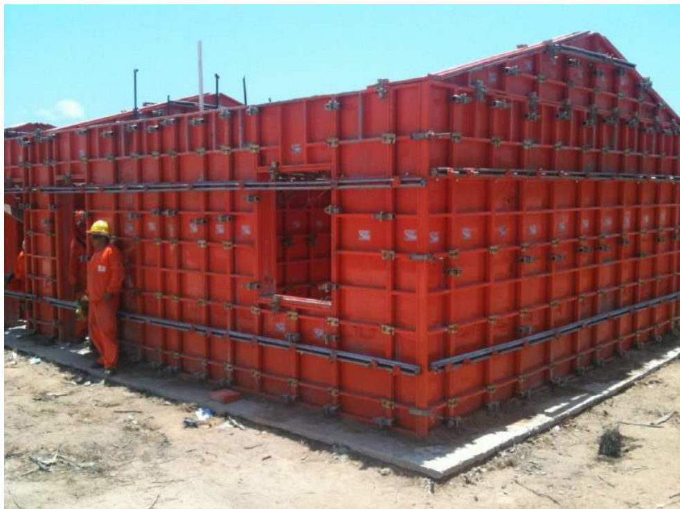
Figura19 – Sistema de fôrmas de aço
