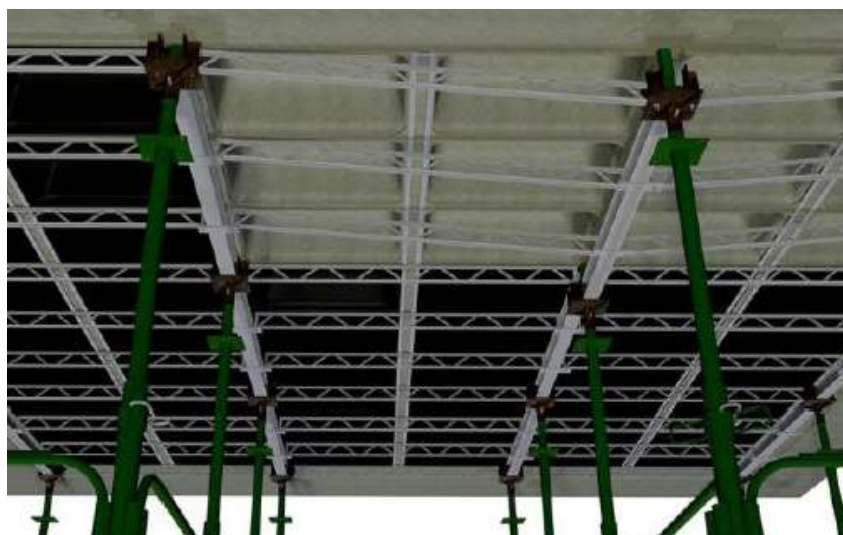
Figura 23 – Sistema de escoramento para lajes nervuradas
