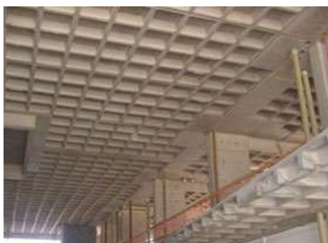
Figura 12 – Laje com nervuras nas duas direções
