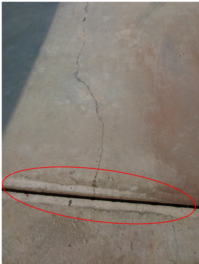
Figura 13 – Detalhe da junta de dilatação executada no empreendimento vistoriado
