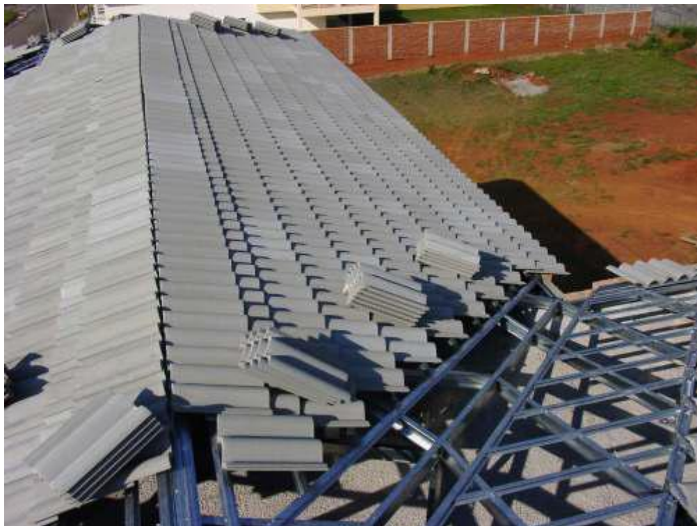
Figura 5: estrutura de aço
