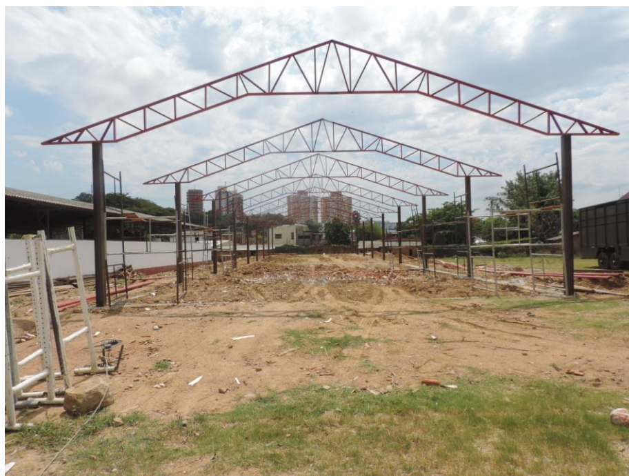
Figura 2: montagem da estrutura de aço
