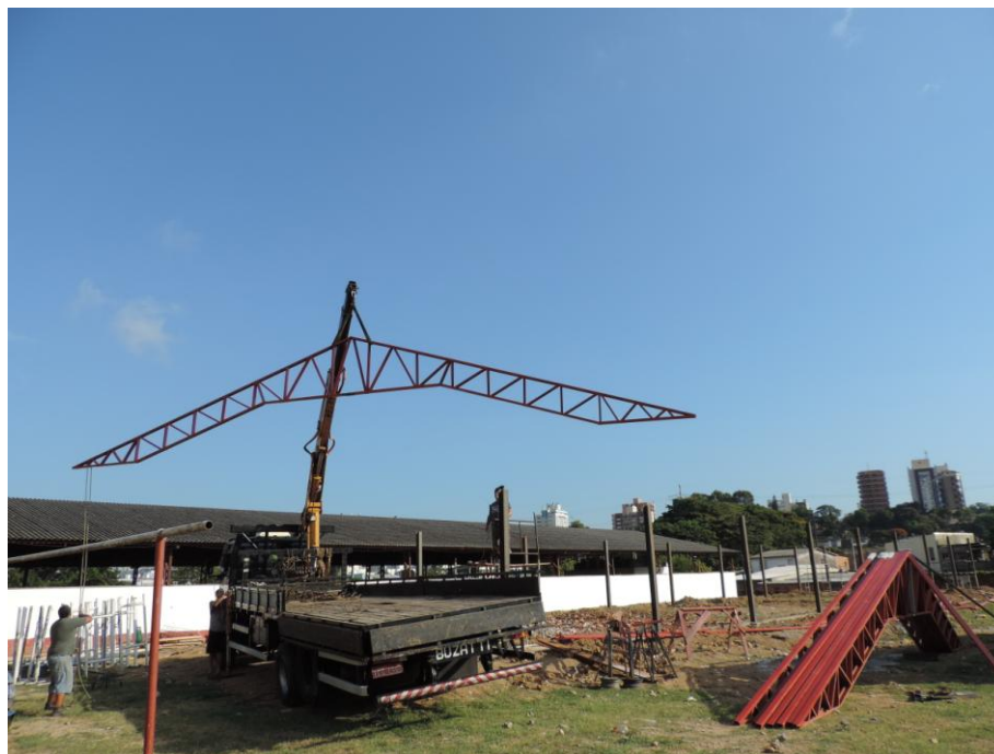
Figura 1: içamento da estrutura de aço
