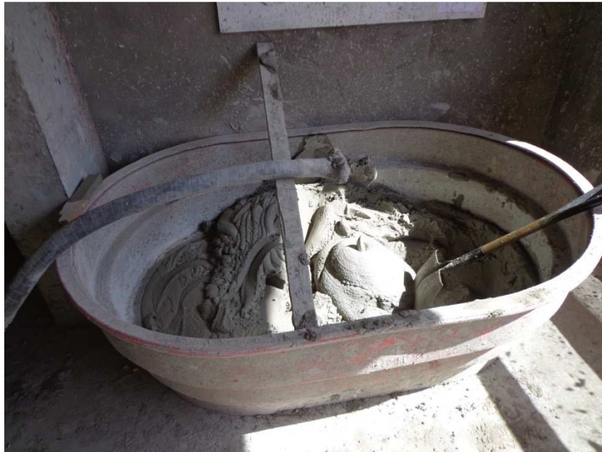
Figura 15 - caixa de armazenagem do pavimento térreo
