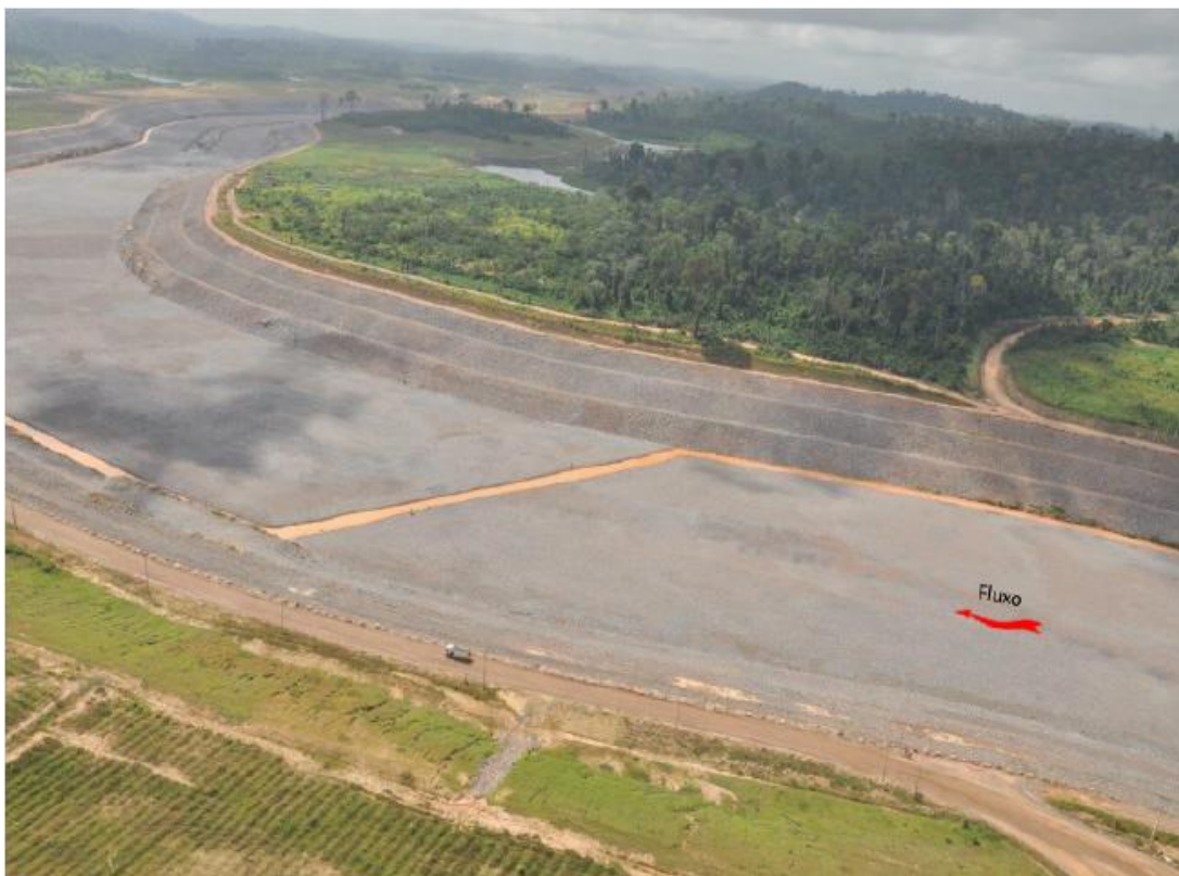
Figura 17: Secção do Canal concluída.
