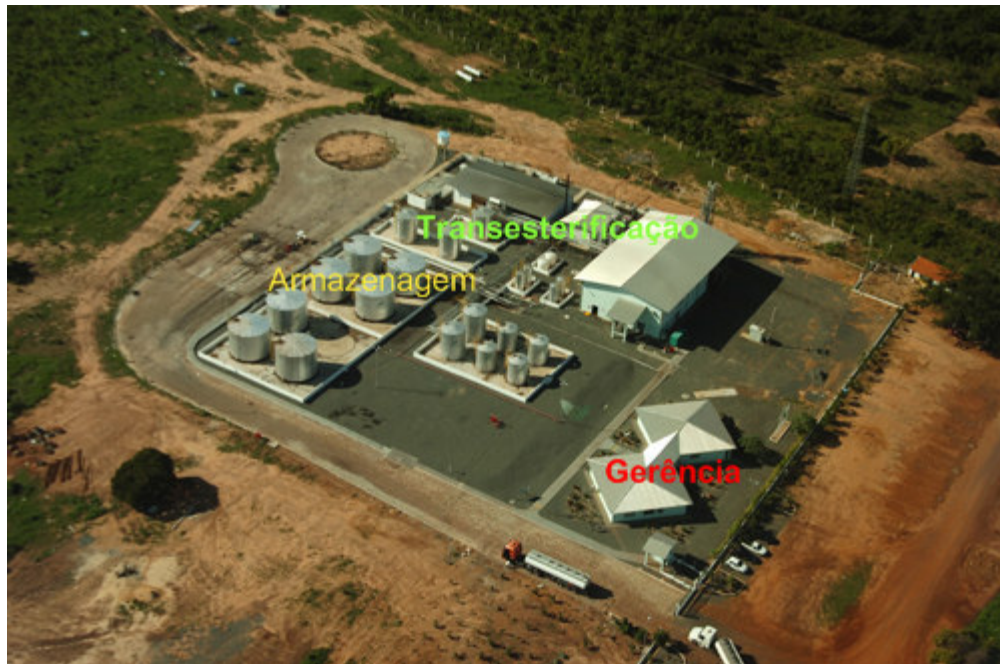
Figura 11 - Foto Aérea da Usina de Floriano
