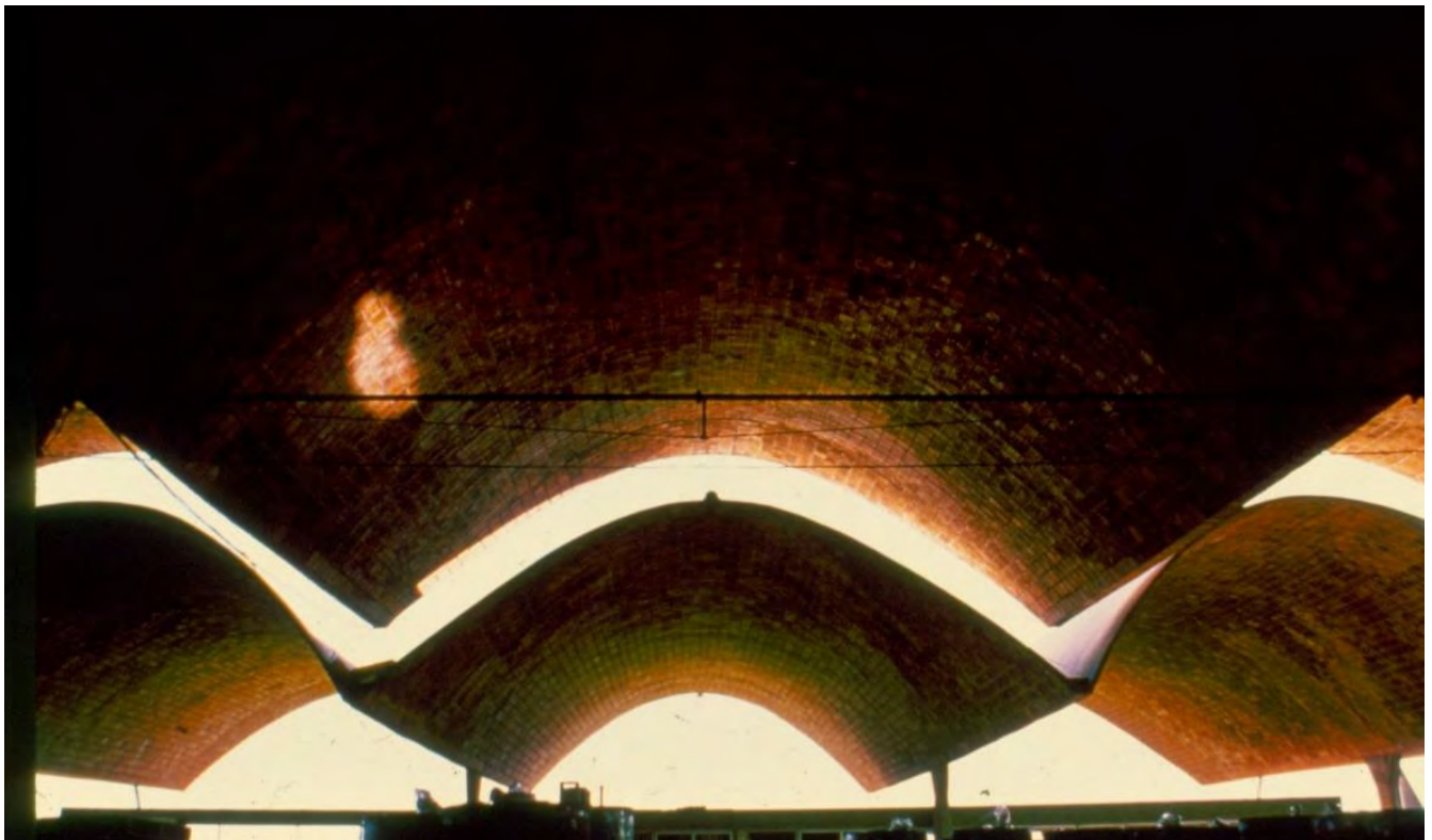
Figura 70: independência estrutural entre abóbadas de cobertura
