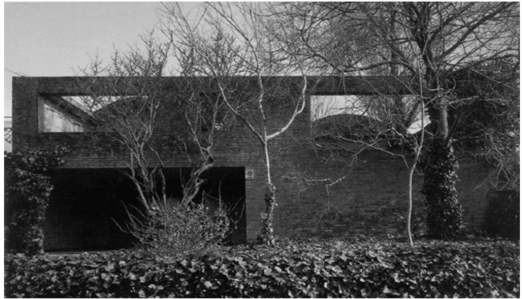
Figura 113: vista da casa Dieste desde o passeio público
