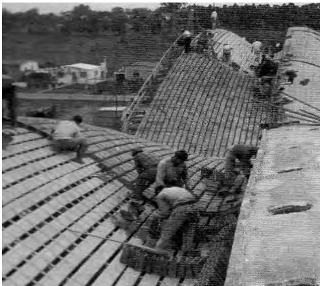
Colocação das peças cerâmicas sobre o assoalho de madeira, utilizando ripas de madeira como espaçador
