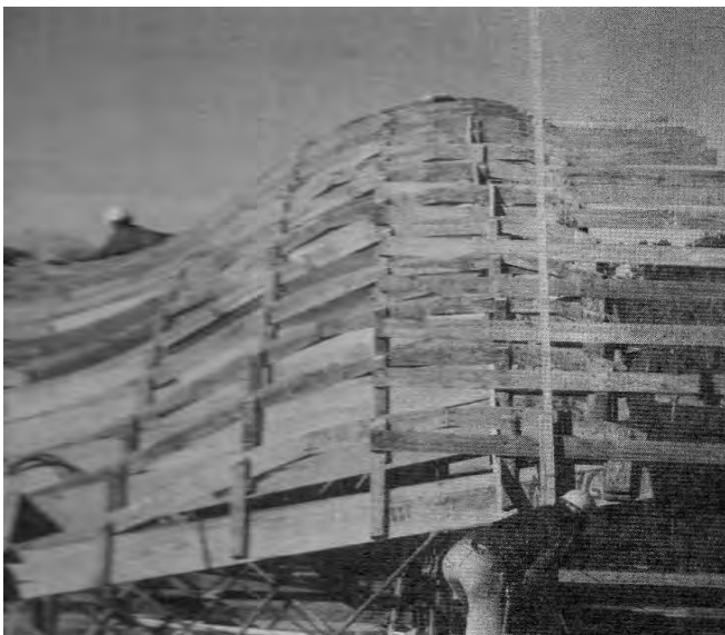
Costelas de madeira da forma, antes do cobrimento pelo assoalho onde se apoiam as peças cerâmicas.
