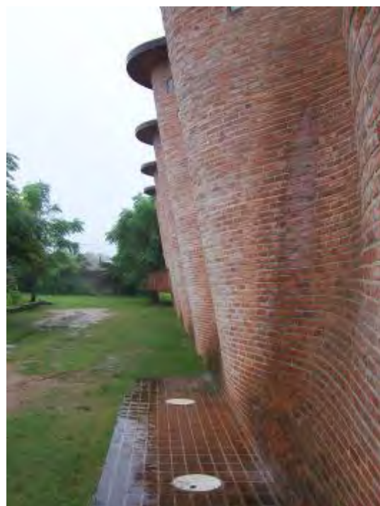
Figura 90: vista da parede conóide. No nível do solo desenvolve-se em linha reta. No topo, a diretriz é curva.
