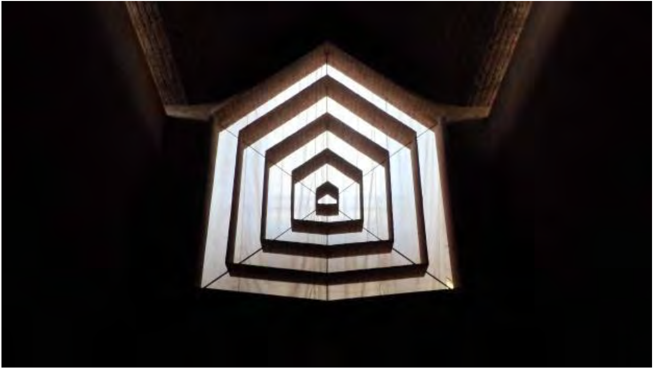
Figura 108: rosácea. Dupla camada de tijolos com armadura nas juntas e perfil tubular de aço nas arestas para suporte
