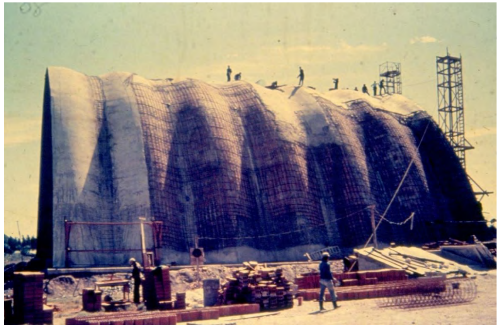
Figura 62: silo CADYL, vista exterior, em obras
