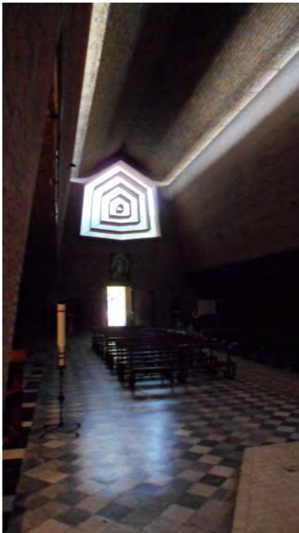
Figura 107: vista da nave principal desde o altar
