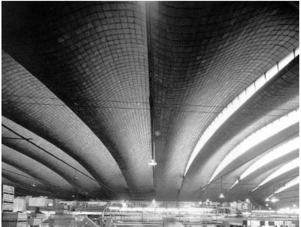
Figura 50: abóbadas gaussianas na Cítricos Caputto
