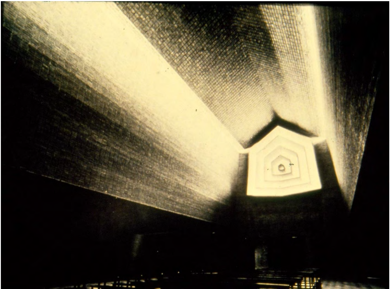
Figura 83: lajes e paredes laterais das naves da igreja de Durazno formada por superfícies dobradas. Ao fundo, rosácea.
