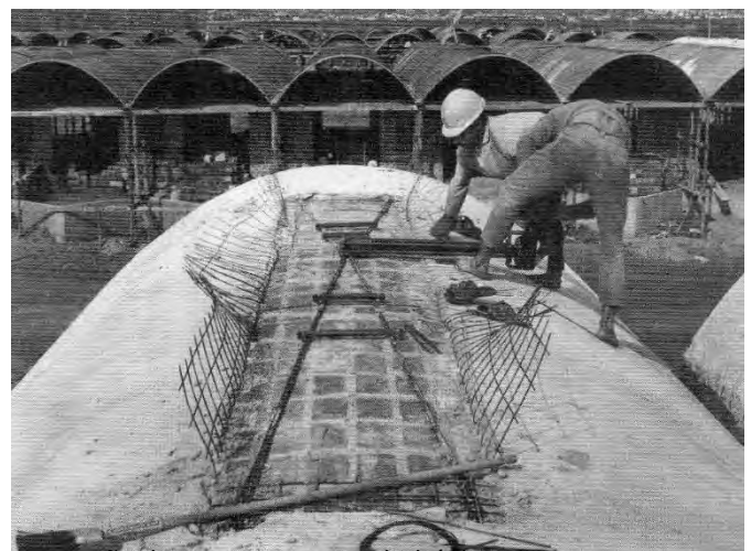
Protensão de aço com macaco hidráulico
