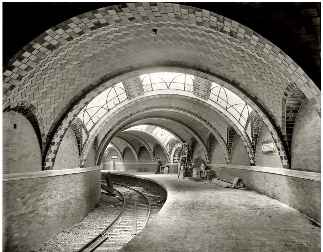
Figura 21: Abóbadas de Guastavino na City Hall Station em Nova Iorque
