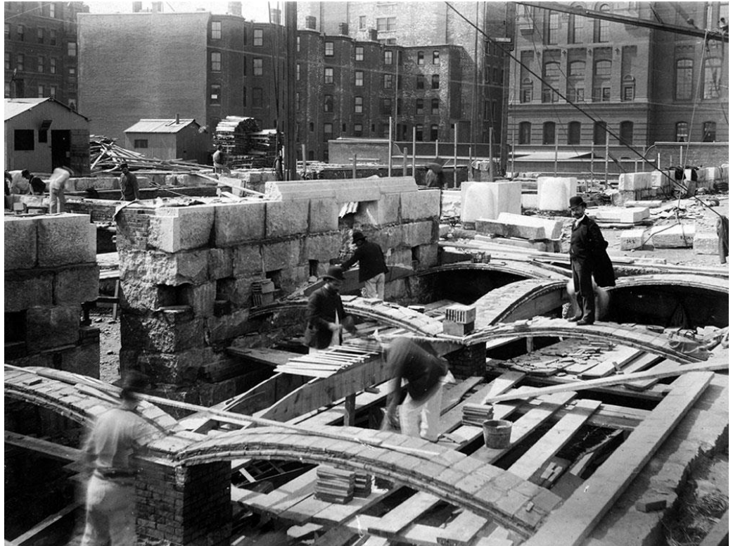
Figura 20: Rafael Guastavino (à direita) durante a construção de estruturas em abóbada da Biblioteca Pública de Boston
