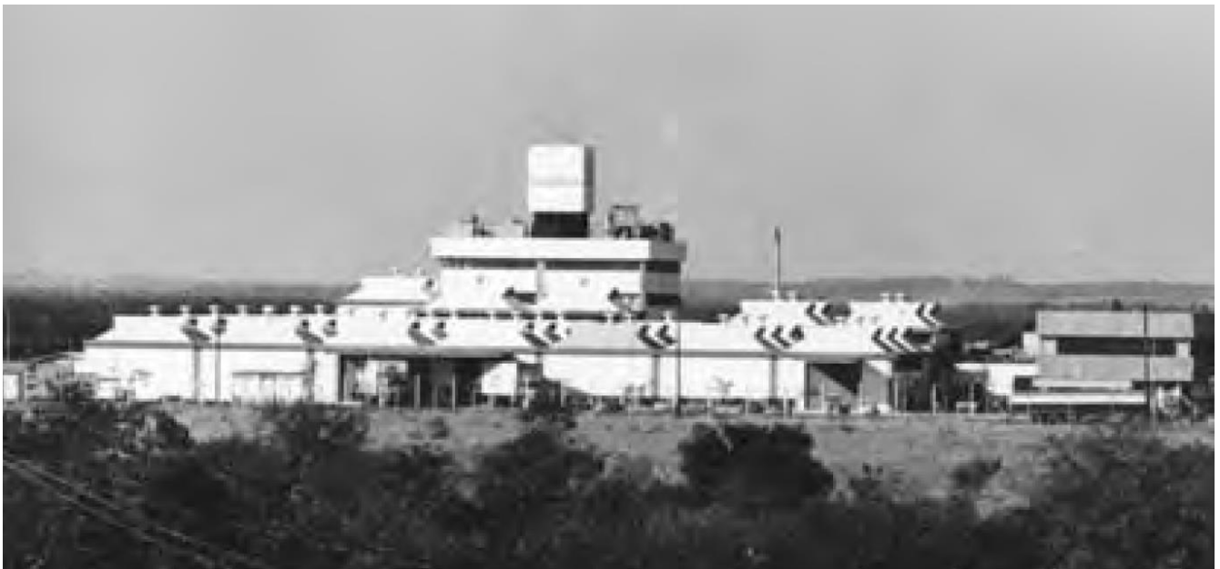
Figura 84a: a Fábrica de Cosméticos Memphis, em Porto Alegre, Projeto de Cláudio Araújo, Cláudia Obino Correa com a participação de Eladio Dieste é exemplo significativo da utilização de superfícies dobradas e exemplo do território vasto e pouco recorrente da utilização da Cerâmica Armada. Ver mais em MARQUES, S. M. A revisão do movimento moderno. Arquitetura do Rio Grande do Sul dos anos 80. Porto Alegre: Ed. Ritter dos Reis, 2002 e MARQUES, S. M. MEMPHIS: uma análise tipológica necessária. ARQTEXTO (UFRGS), v. zero, p104-115, 2000.
