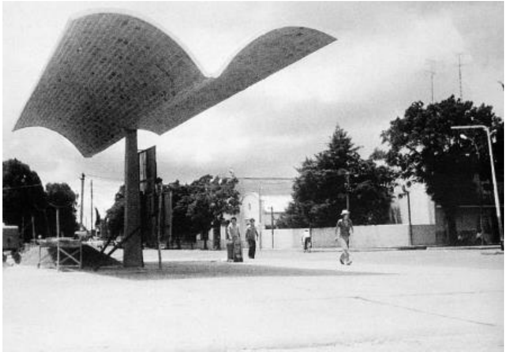
Figura 51: estrutura em “asa de gaivota” em construção em Salto.
