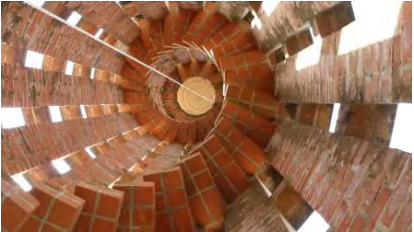
Figura 99: escada no interior do campanário
