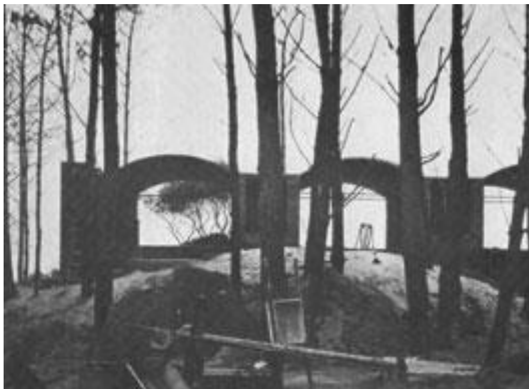
Figura 36: Casa Berlingieri em construção, somente primeira camada de tijolos
