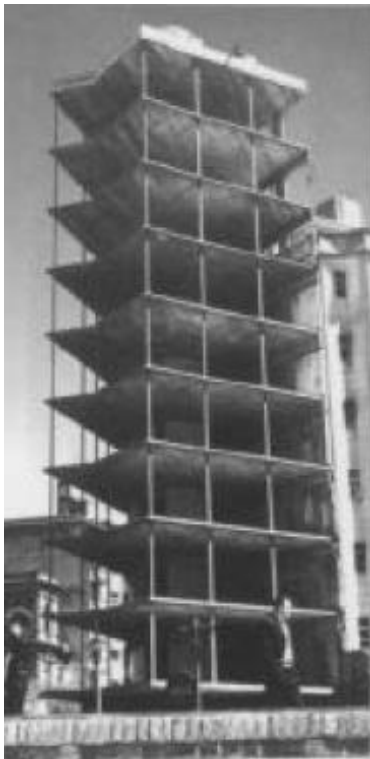
Figura 9: Edifício El Pilar sem a pele de vidro externa. Estrutura aparente estaiada
