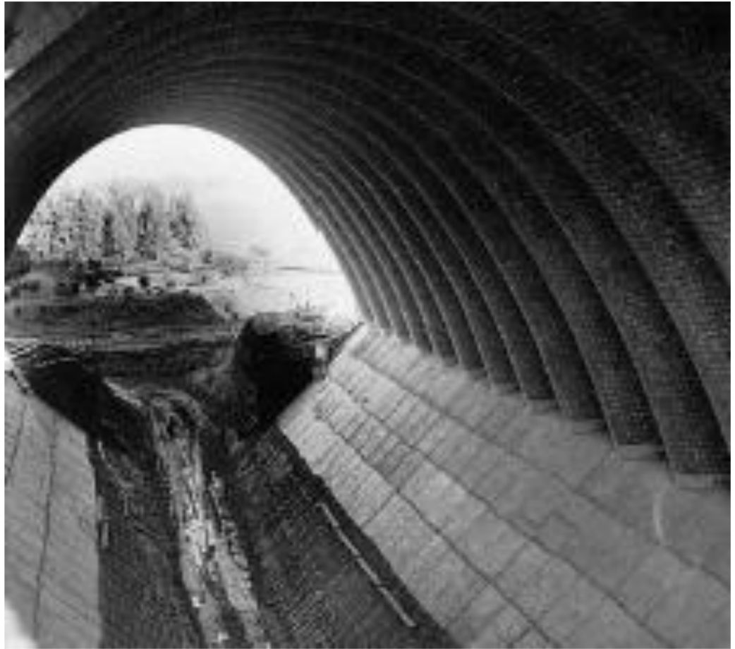
Figura 61: silo CADYL, vista interior
