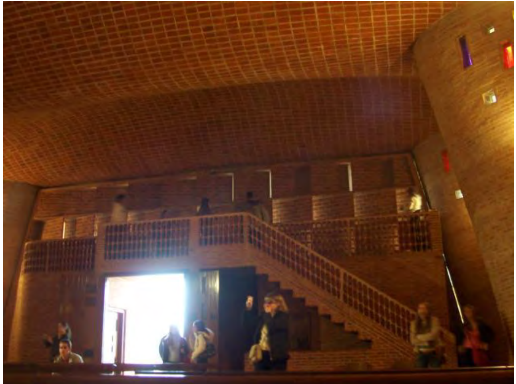
Figura 92: escada de acesso ao coro no primeiro plano. Atrás, muro de painéis independentes.
