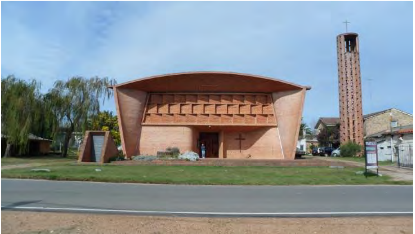
Figura 88: vista frontal da Igreja, fachada norte
