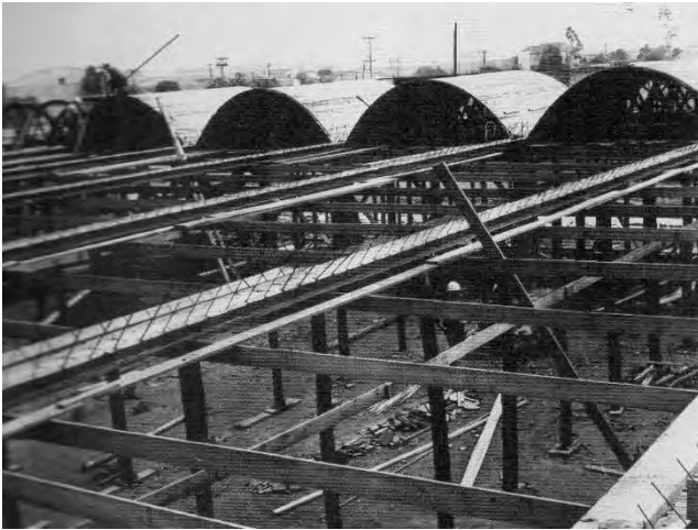
Abóbadas autoportantes. No primeiro plano os vales de concreto armado onde as abóbadas são ligadas lateralmente. Atrás, formas de madeira.
