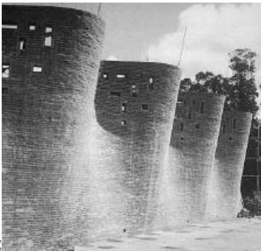
Figura 77: paredes da Igreja de Atlântida em construção
