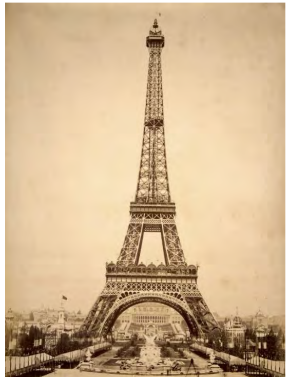
Figura 24: Torre Eiffel, cuja geometria corresponde às cargas de vento obtidas pela grafostática
