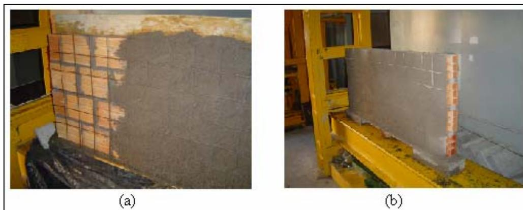
**Figura 5-12: Aplicação de uma camada de chapisco sobre a tela e a alvenaria.**
