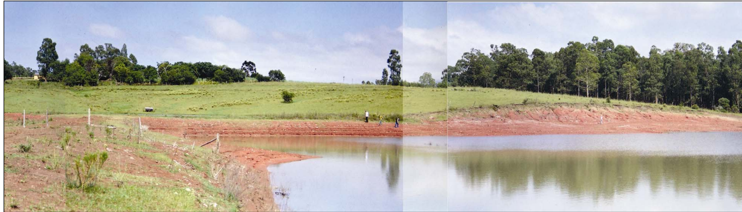
Figura 5 – Fotomontagem do LV1/Topo – Margem Oeste em vista geral
