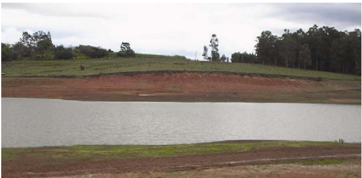
Figura 3.1.3 – LV1 Topo/ Margem Oeste – Vista geral
