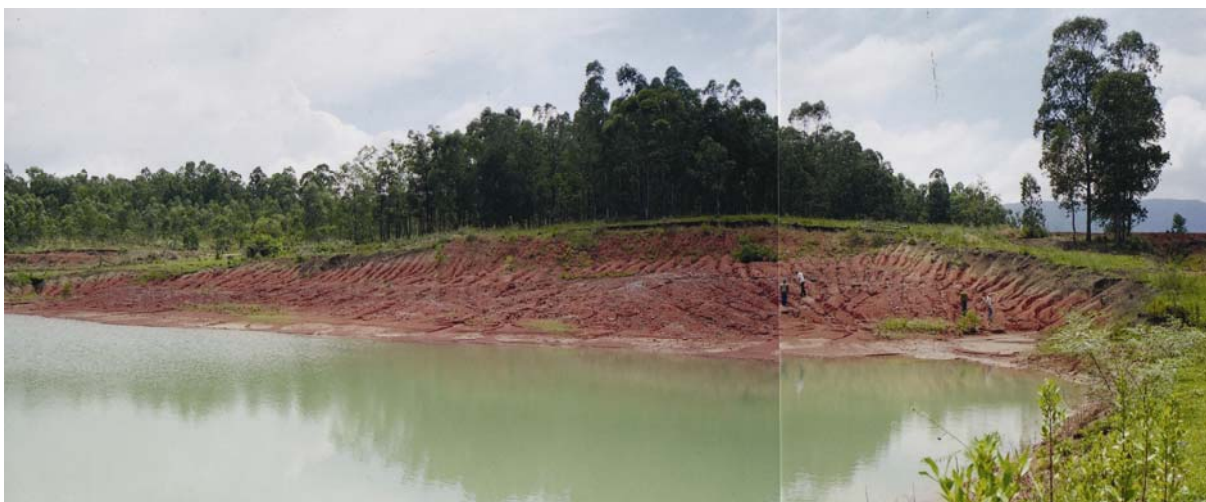
Figura 3.2.1 – Vista geral do LV2.
