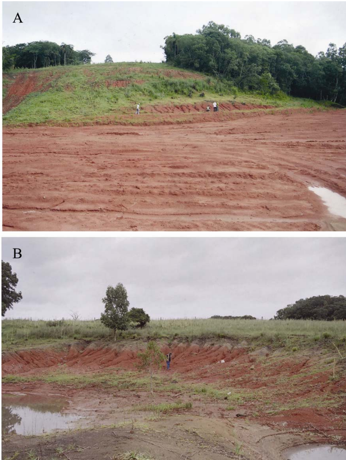
Figura 3.1.1 – Linha Várzea 1/ Base em vista geral; A – Margem E; B – Margem W.
