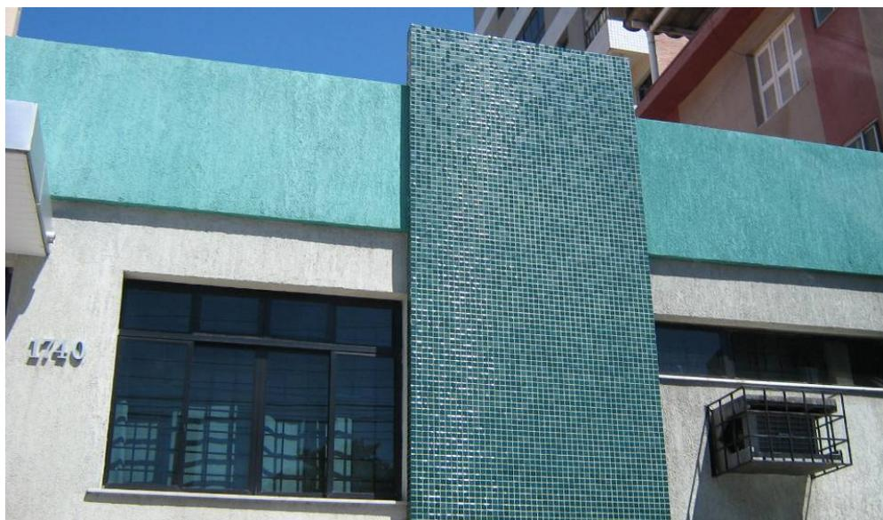
Figura 78: Detalhe de pastilha de vidro usada em fachada
