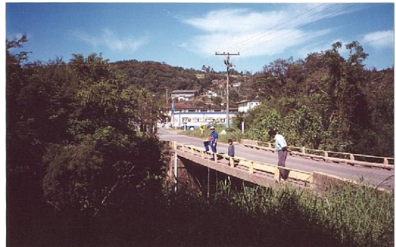
FIGURA 5 – Ponto FEI001, no rio Feitoria, a jusante da ponte de Lindolfo Collor
