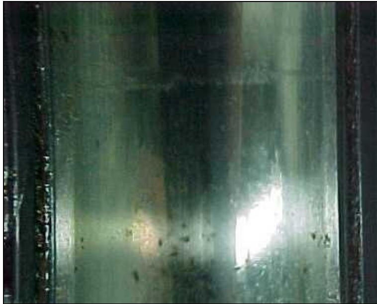
Figura 54 - Defeito localizado e sinais de oxidação na pista externa de um rolamento 6306 NR. Posição 2 (LA) do mancal da bomba centrífuga horizontal simples estágio 02B03A
