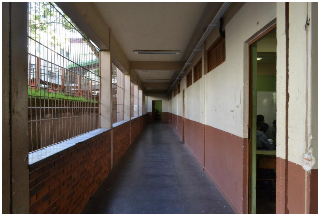
Fotografia 5: Corredor no prédio 2, em frente à sala de aula da turma A
