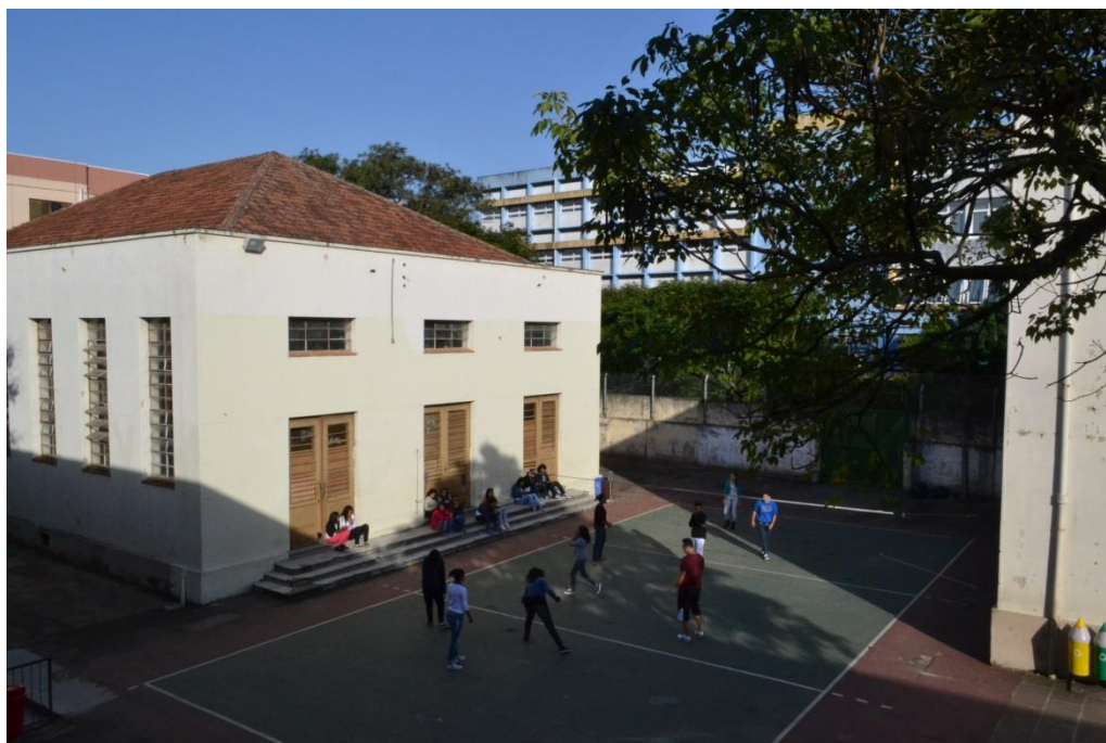
Fotografia 1: Pátio interno e ginásio interditado (esq.)
