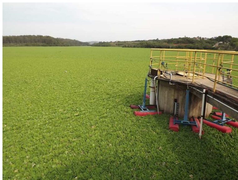
Figura 11: Reservatório da Lomba do Sabão, em outubro de 2012
