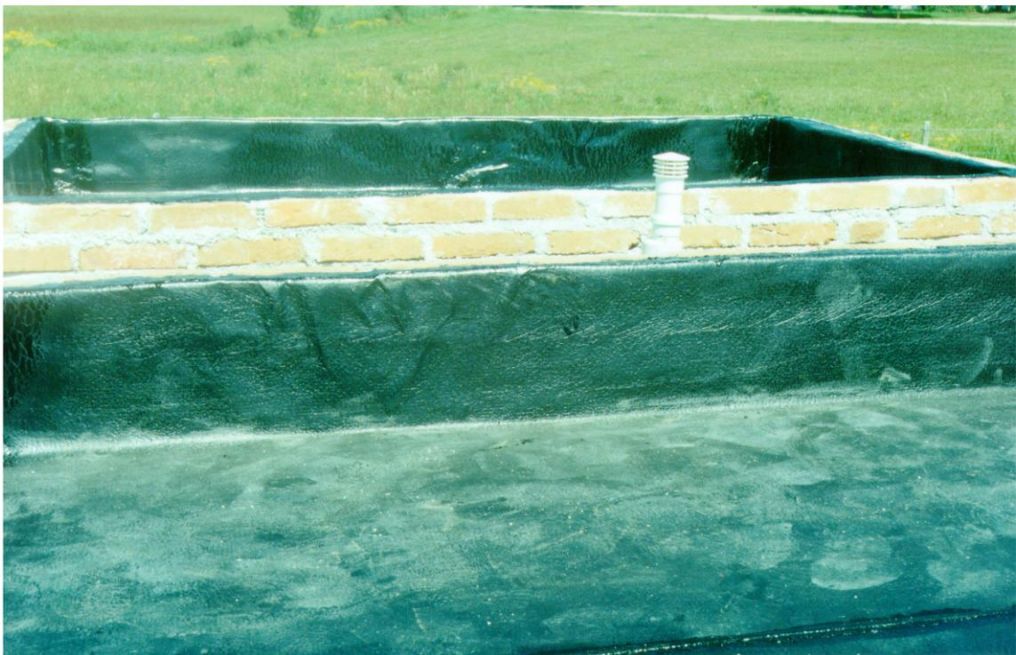
Figura 11 - Detalhe das lajes com a impermeabilização já executada.
