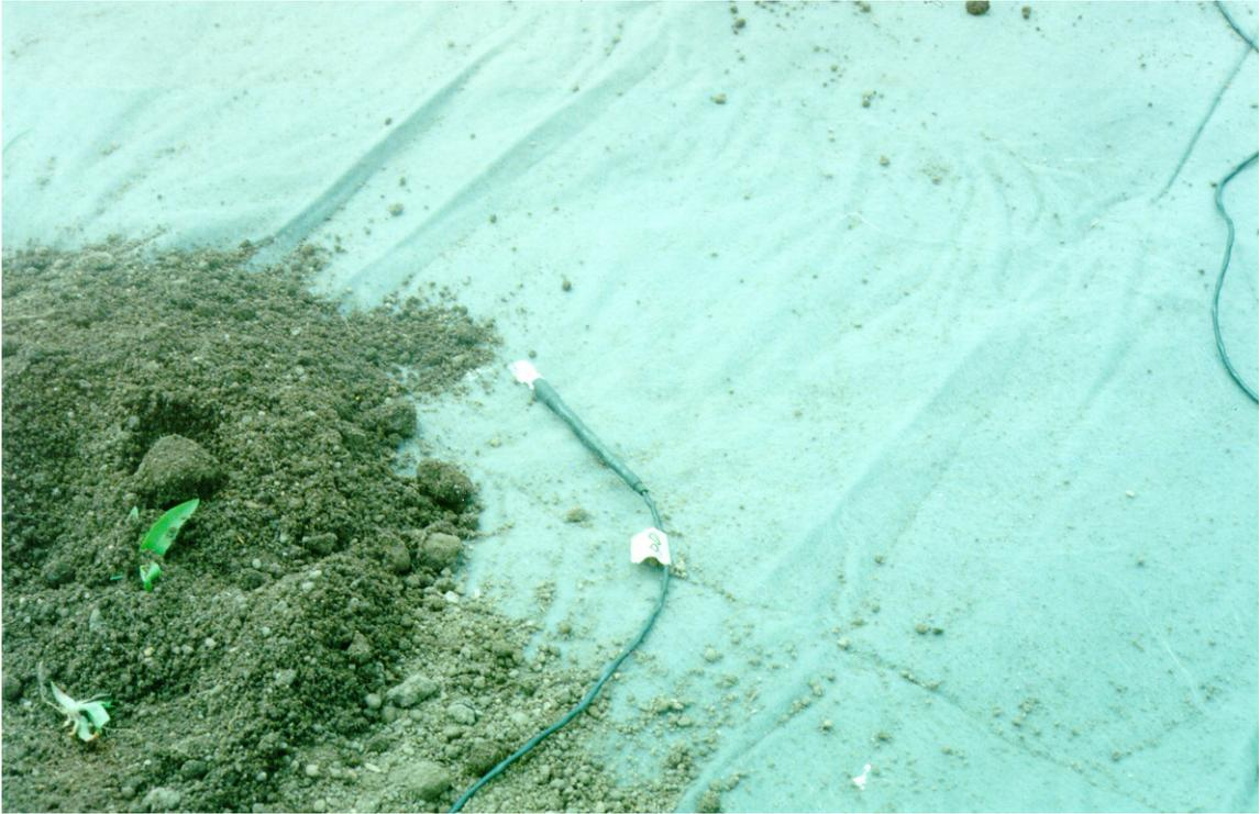
Figura 16- Instalação do sensor de temperatura na interface solo-manta geotêxtil
