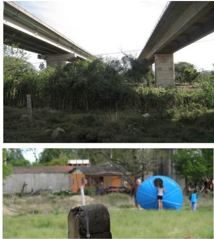
Risco percebido: queda de objetos da ponte-rodovia
