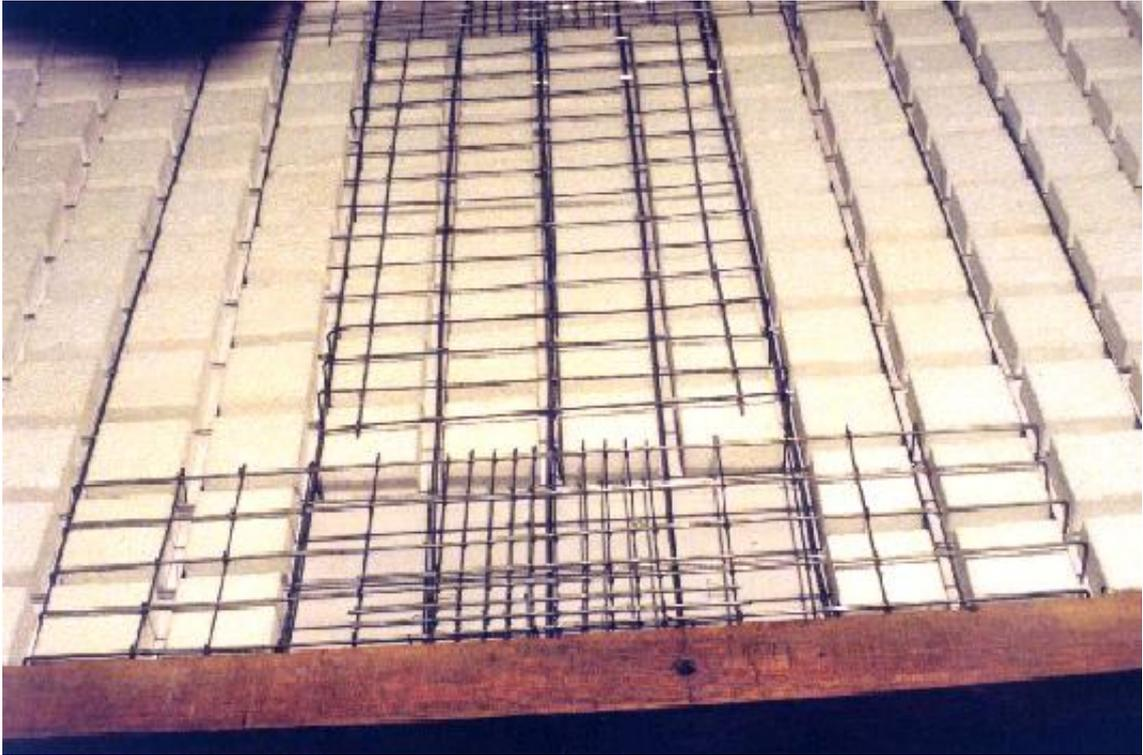
Foto 3.9 - Detalhe da armadura negativa sobre um dos pilares centrais
