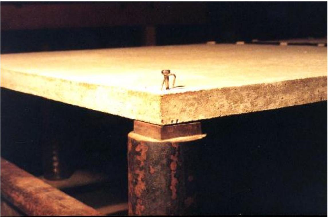
Foto 3.22 - Detalhe do pilar metálico torneado no topo e do parafuso já posicionado (P6)
