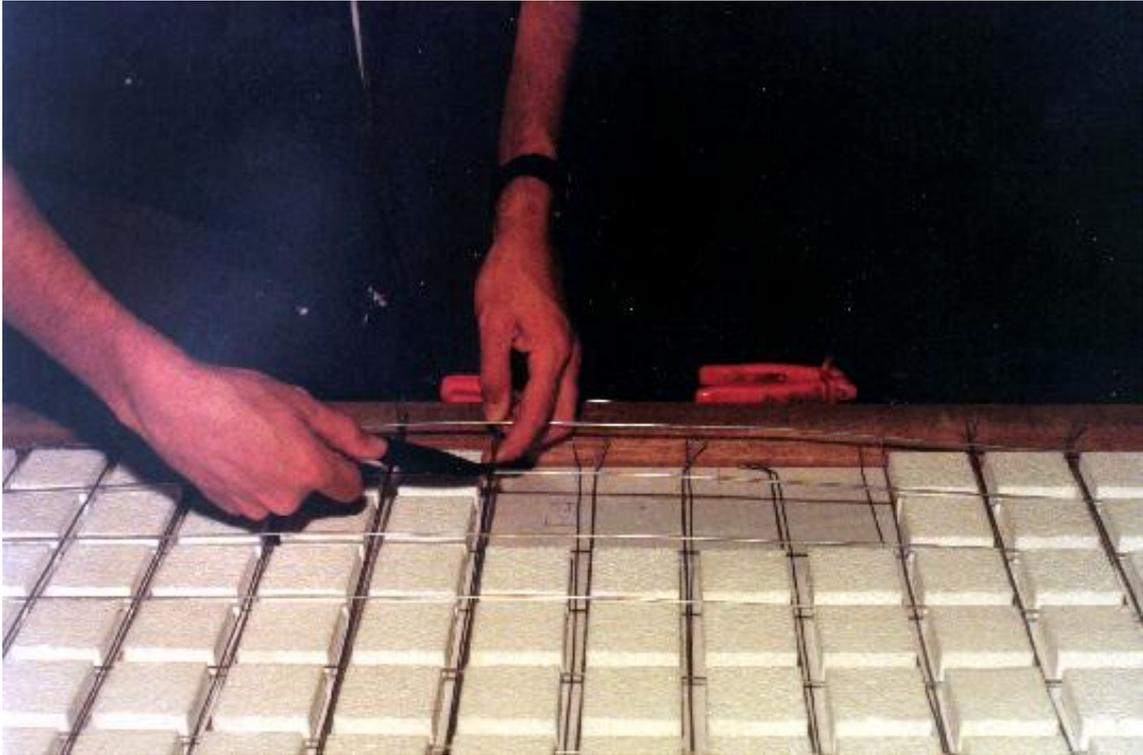
Foto 3.7 - Amarração dos fios constituintes da armação positiva da laje
