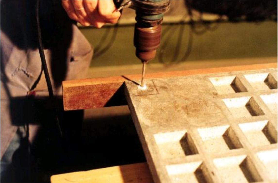
Foto 3.21 - Furação da laje no centro da projeção do pilar P6
