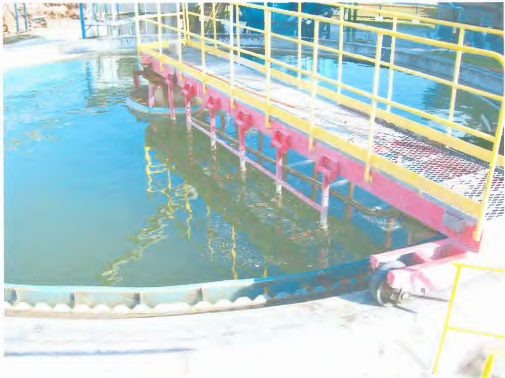
Figura 4.10 – Tanque de tratamento primário de flotação do resíduo resultante da fabricação do papel.
