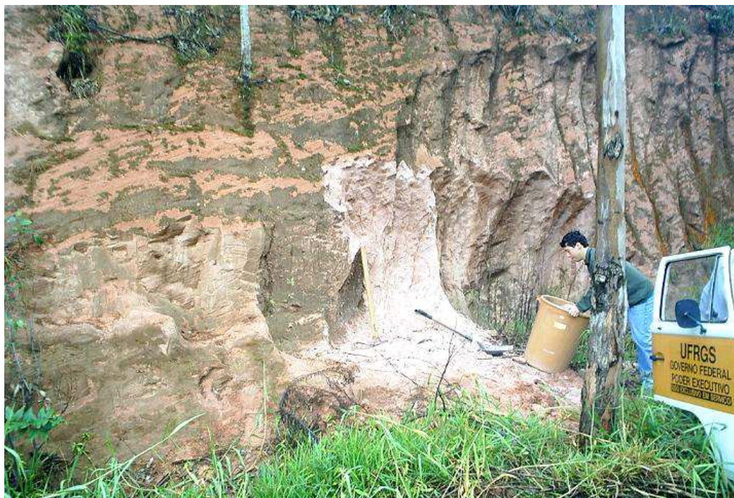
Figura 3.3: talude onde foi retirada a amostra de solo
