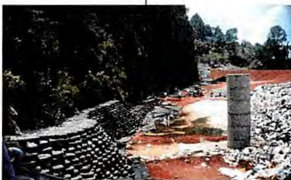
Figura 30: Aterro Sanitário, Caxias do Sul.
