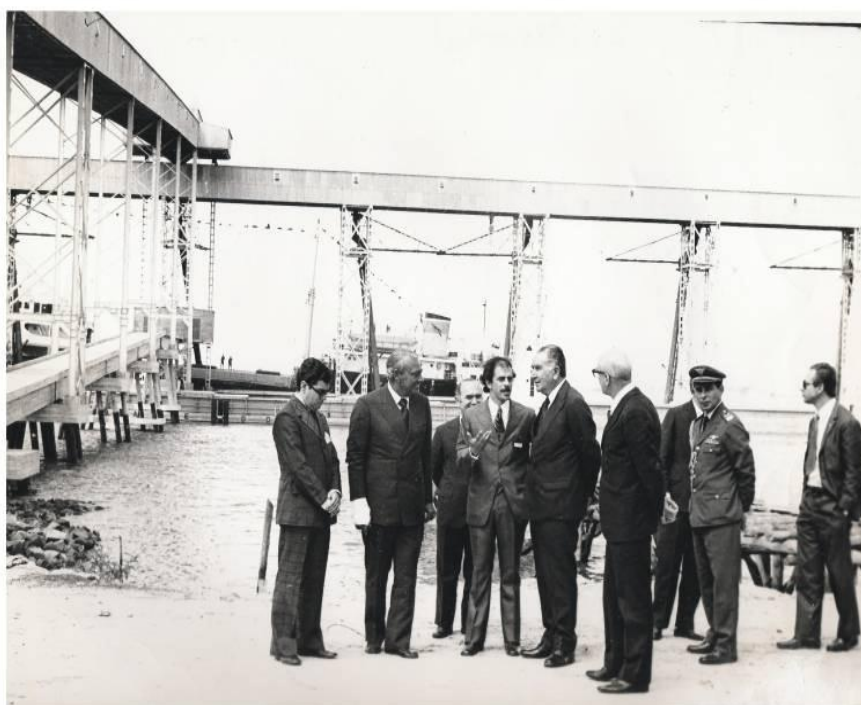
O presidente Emílio Médici visita as obras do Terminal Graneleiro da COTRIJUI. Rio Grande, 16/10/1972.
