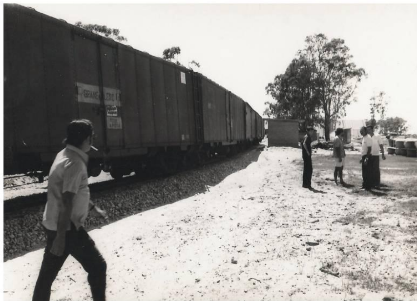
1º recebimento de grãos do Terminal Graneleiro. Rio Grande, 25/11/1971.
