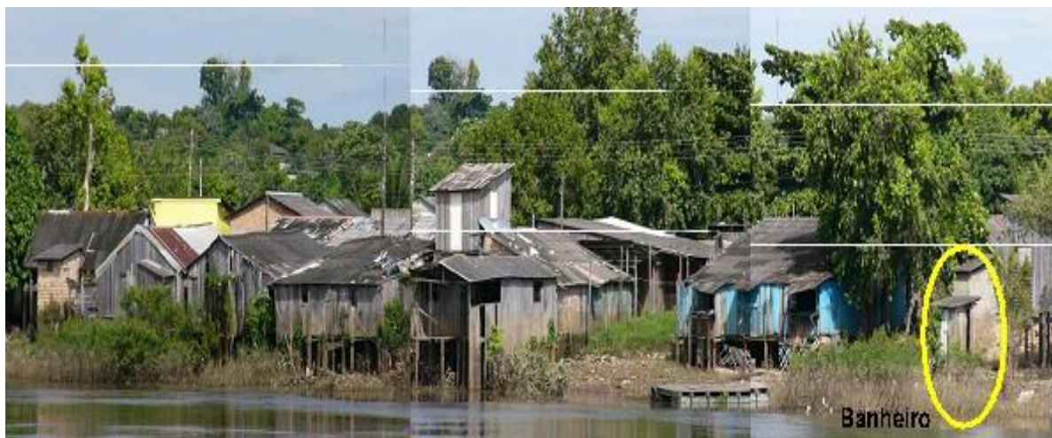
Figura 21. Lançamento de esgotos “in natura” no Rio Branco (Bairro Caetano Filho – Beiral)
