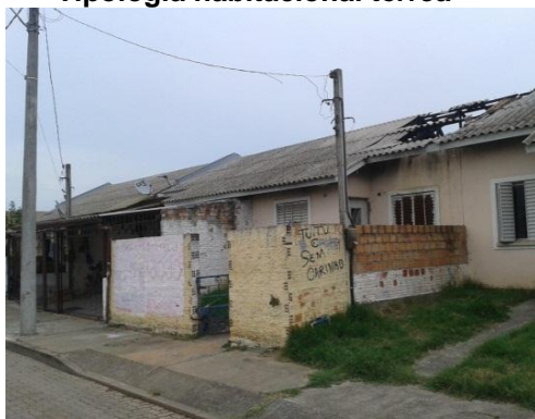
Figura 104 - Garagem da unidade habitacional térrea Fonte: Acervo pessoal (2014)
