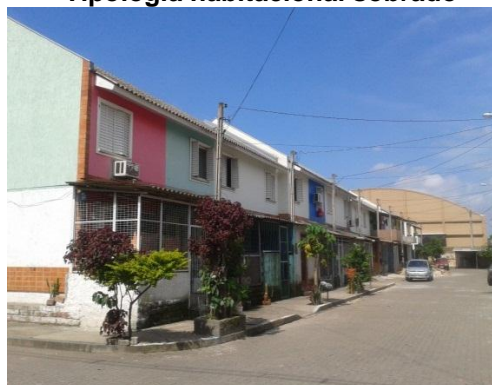
Figura 105 - Falta de garagem da unidade habitacional sobrado Fonte: Acervo pessoal (2014)
