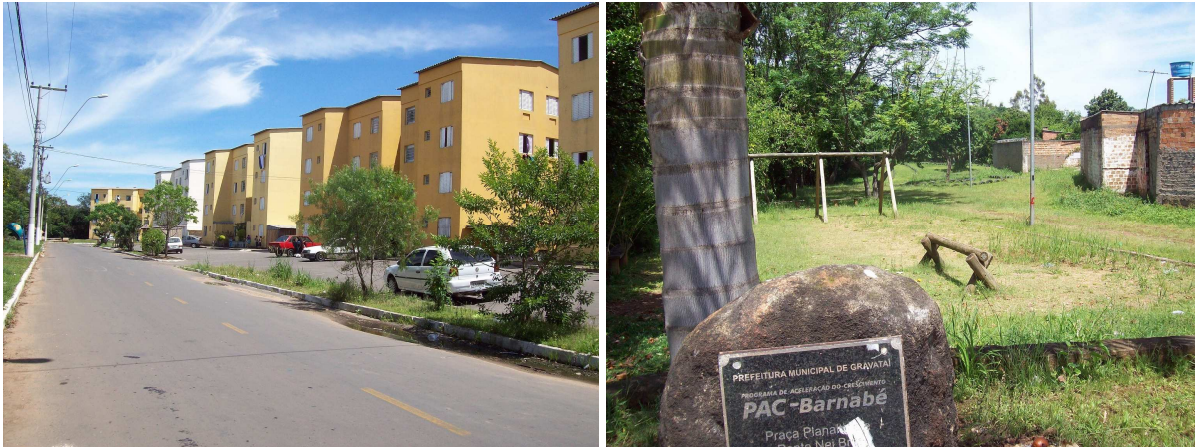
Figura 10: Travessa do Arroio: retirada e inserção das pessoas que moravam em casebres nas margens do Barnabé para os prédios do PAC. Figura 11: Av. Barnabé e Travessa do Arroio: revitalização das margens com a construção local para jogo de bocha, ciclovia e praça com banheiros.
