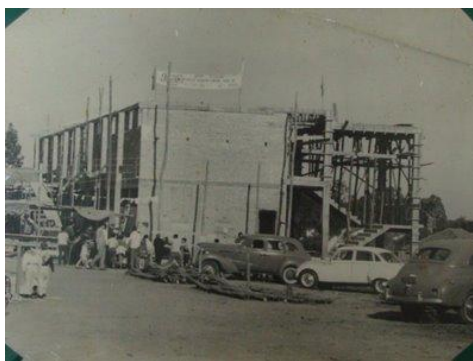
Fig. 90 Construção do 1º bloco do 1º pavilhão – 1965
