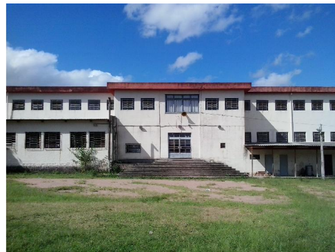
Fig. 89 Vistas internas do pátio.
