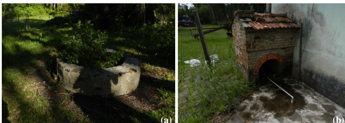
Figura 5 a e b- Poço Escavado e Ponteira, respectivamente, localizados no município de Palmares do Sul.
