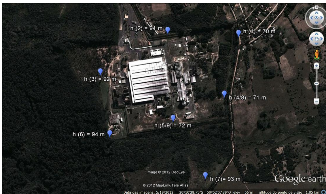
Figura 7: Nível h (m) em cada poço de abastecimento da fábrica de Águas Claras do Sul;
