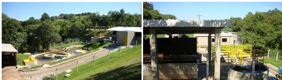
Figuras 7 e 8. Vistas do sistema de tratamento de efluentes da UNISINOS.
