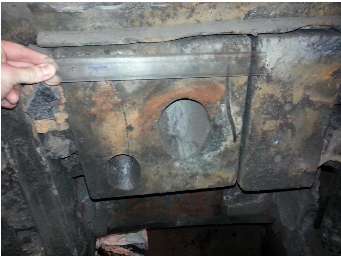
Figura 3.1 Bloco refrigerado que suporta as injetoras Co-Jet e de carbono.
