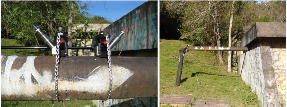
Figura 4.17 - Medidor de vazão ultrassônico instalado na tubulação que sai da casa de máquinas, para levantar a curva característica da bomba.
