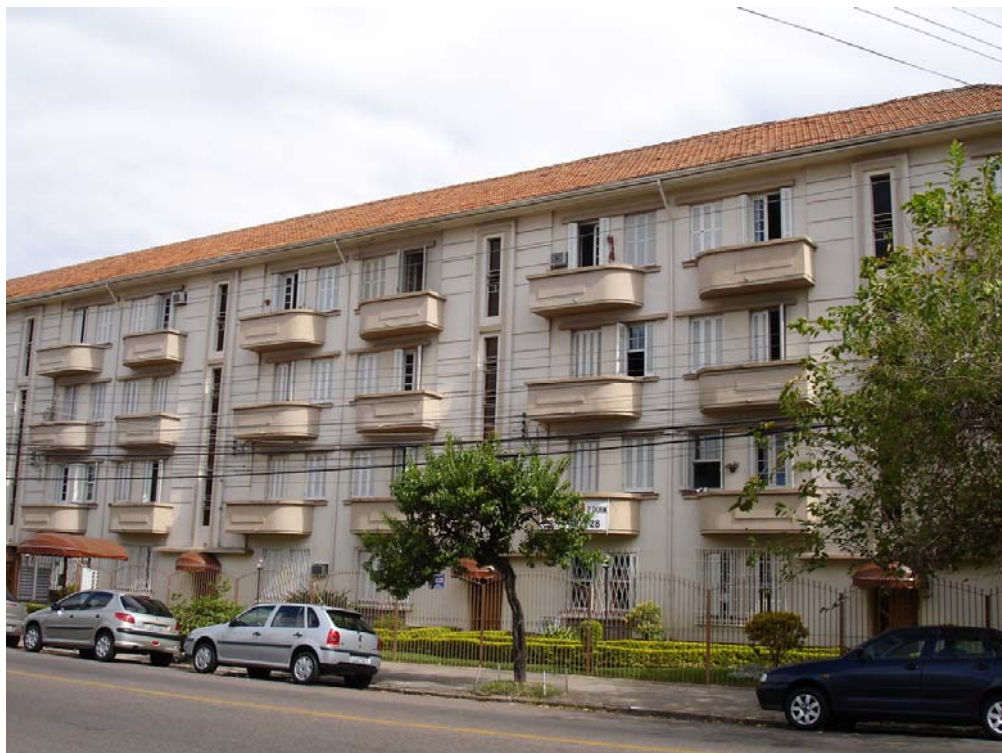
Figura 6.4 - exemplo da tipologia funcional 1 - residencial multifamiliar até 5 pavimentos encontrada na área
