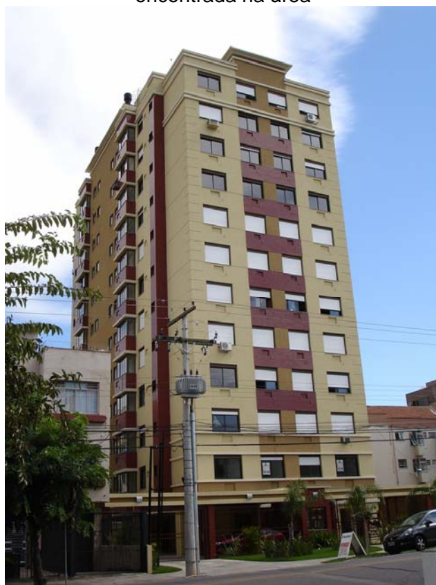
Figura 6.5 - exemplo da tipologia funcional 2 - residencial multifamiliar c/mais de 5 pavimentos encontrada na área
