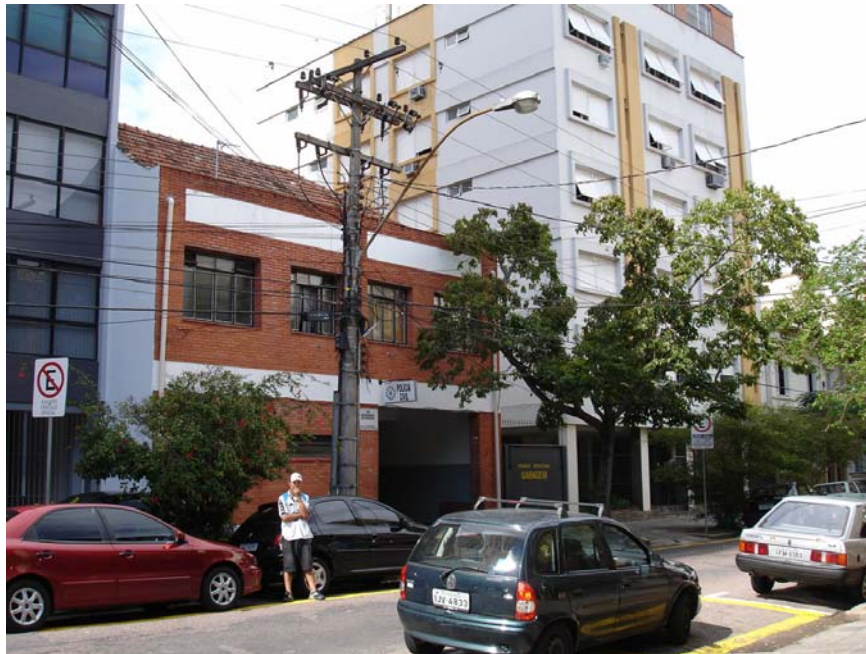
Figura 6.12 - exemplo da tipologia funcional 9 – prédios institucionais ou especiais como: igrejas, museus, escolas, postos de saúde, ONGS, encontrada na área.
