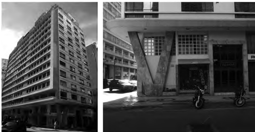
Figura 13: a) Edifício Villanova, construído no terreno do antigo sobrado do Sr. Innocente, entre as décadas de 1950 e 1960; b) Detalhe do piloti em “V”, em alusão à inicial nome “Villanova” (Fonte: Fotografias do autor, 2012).
