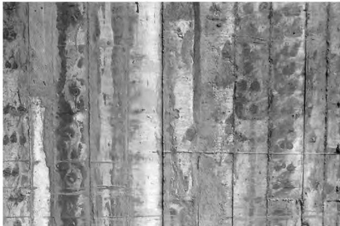
Figura 61: Aspecto da superfície de uma construção em São Paulo, em concreto armado bruto aparente moldada em formas de tábuas. (Fonte: Fotografia do autor, 2014).
