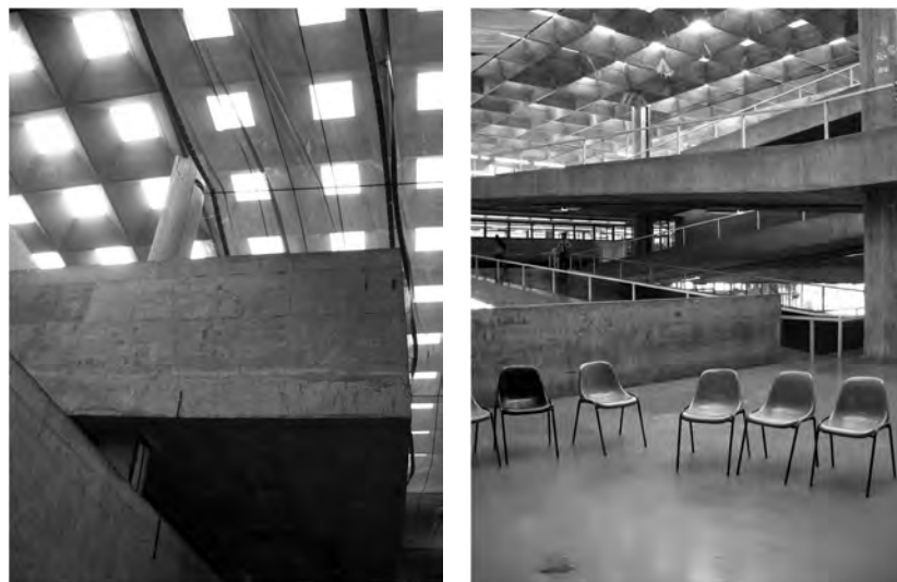
Figura 33: Fotografias do interior da FAU-USP (1961-69): a) Vista do sistema de iluminação zenital; b) ambiência do espaço iluminado pelo sistema de iluminação zenital de um dos espaços organizados ao redor do pátio interno (Fonte: Fotografias do autor, 2010).
