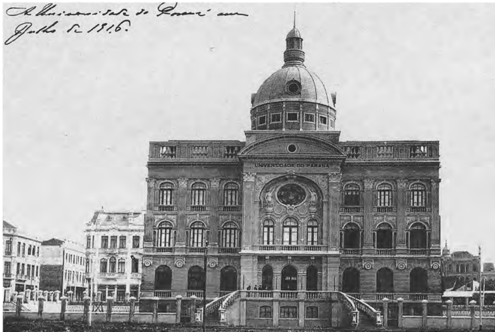
Figura 37: Fotografia do edifício-sede da Universidade do Paraná no ano de 1916, com o primeiro corpo construído, que seria ampliado e modificado com o passar dos anos (Fonte: GUINSKI, 2002).
