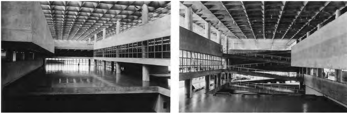
Figura 32: a; b) Fotografias do pátio interno com sistema de iluminação zenital da FAU-USP (1961-69) (Fonte: KAMITA, 2000).
