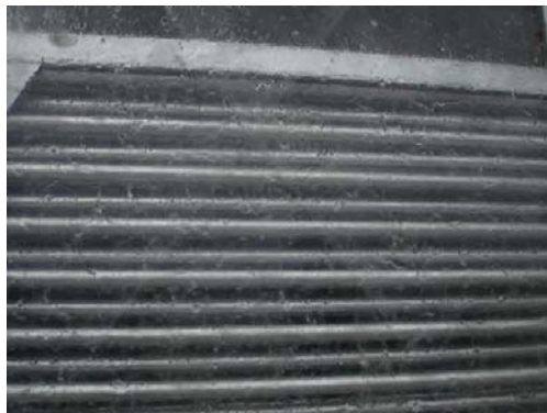
Figura 4.2 - Condensador evaporativo modelo RC200 modelado no presente trabalho com detalhe frontal e lateral da serpentina.
