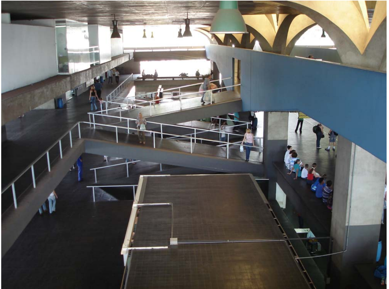
Fig. 105 – Rampas que vencem o desnível de 7,00m - Portal de Jaú
