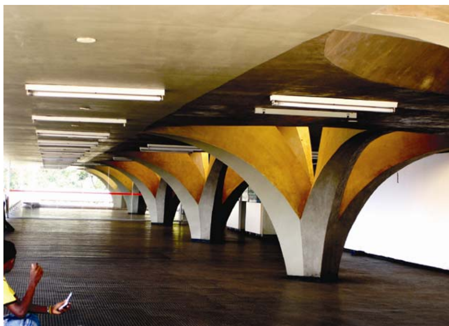
Fig. 35 - Terraço - e m destaque as flores de concreto - Portal Jaú
