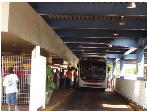
Fig. 39 – Anexo em estrutura metálica - Portal Jaú
