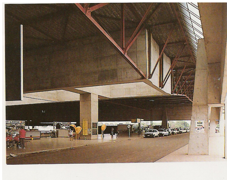
Fig. 98a – Edifício sem fechamentos laterais
