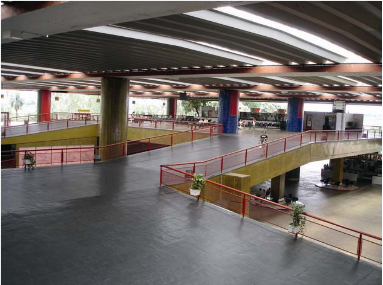
Fig. 88 – Rampas de Circulação - Portal Cuiabá
