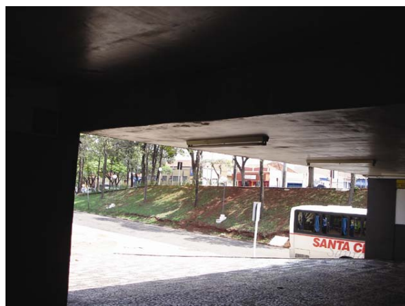
Fig. 51 – Acesso Principal – Portal de Jaú – Vista Interna
