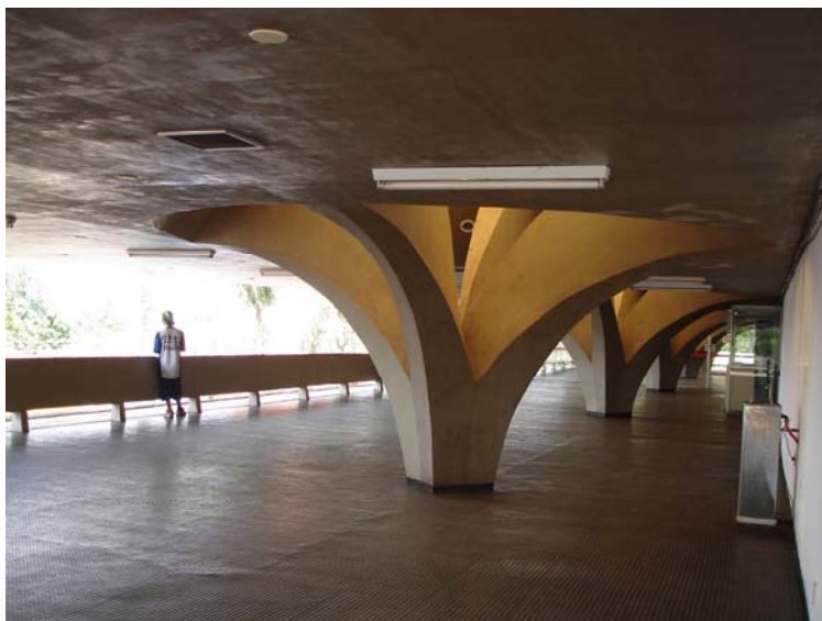
Fig. 52 - Detalhe dos Pilares escultóricos
