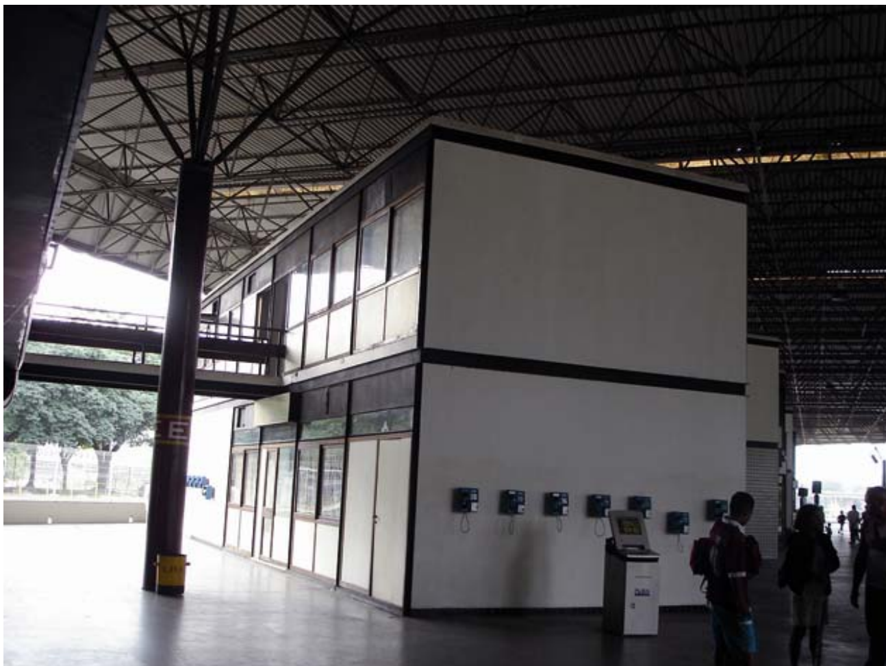
Fig. 69 – Interior Portal Vitória (Administração)
