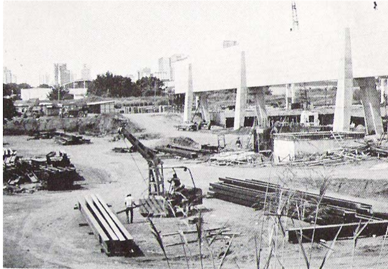
Fig. 99 – Obras Portal Goiânia
