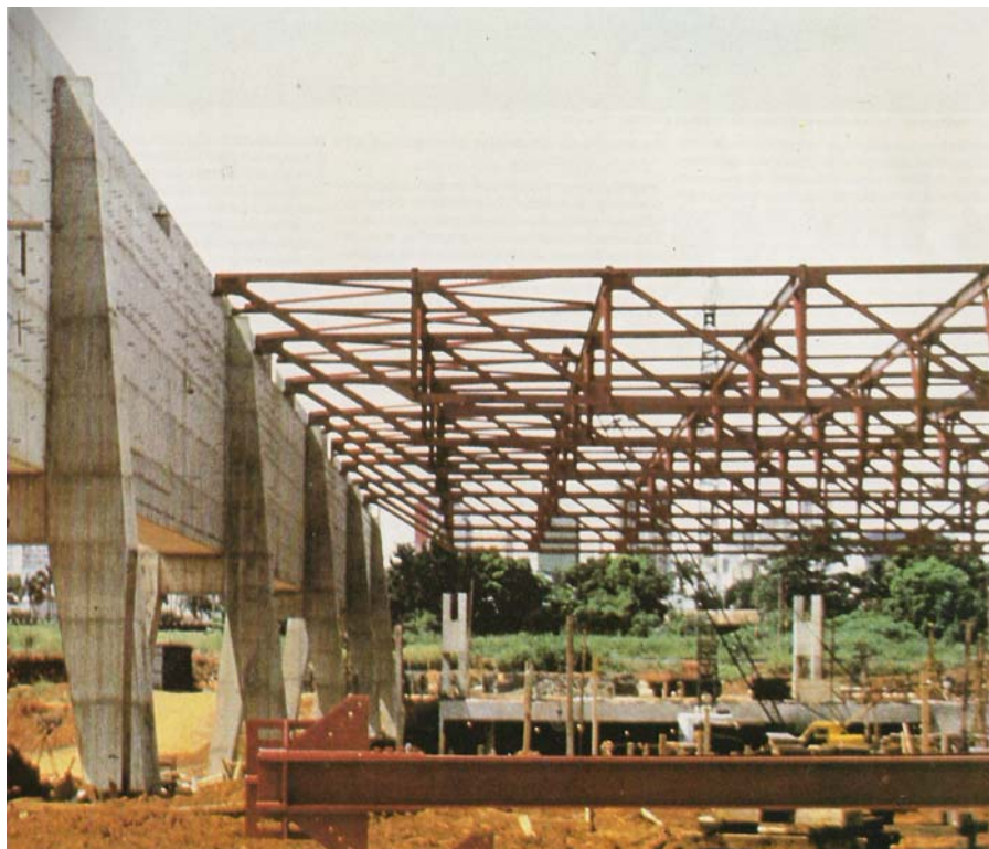
Fig. 92 – Estrutura de Concreto com Estrutura Metálica.
