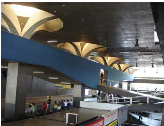
Fig. 43 – Vista Interna - Rampas - Portal Jaú
