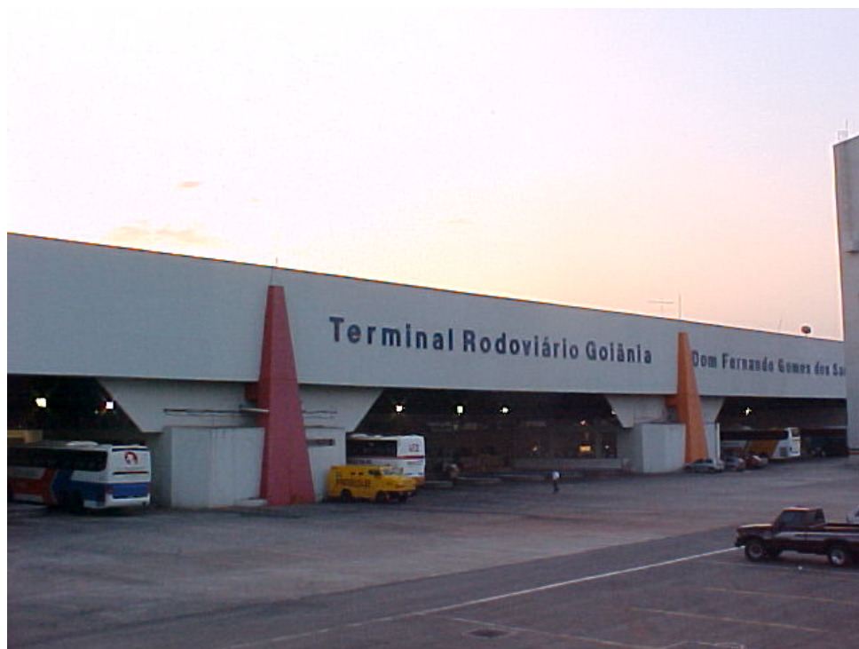
Fig.: 19 – Fachada original do Portal Urbano de Goiânia – Atualmente descaracterizada
