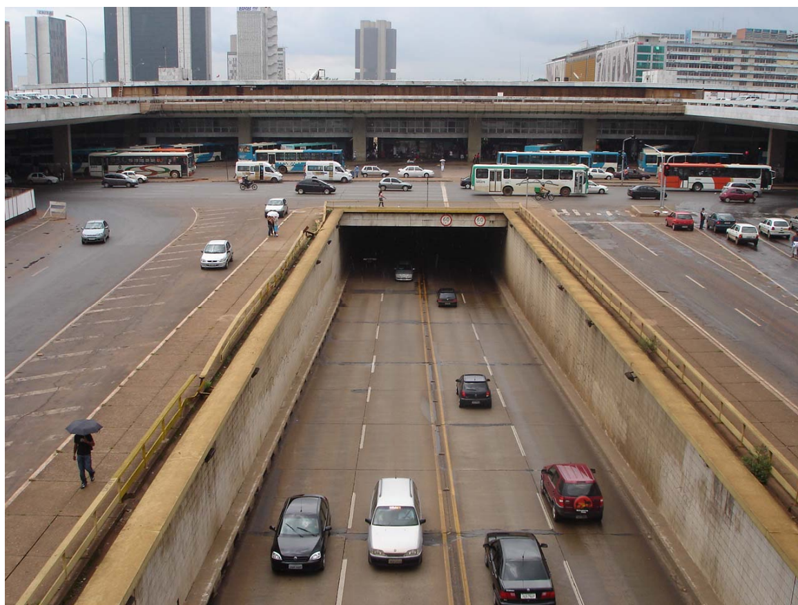
Fig. 73 – Portal Urbano Rodoviário de Brasília – Projeto original na implantação da nova capital
