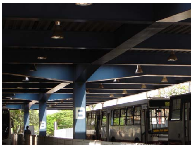
Fig.: 54 – Anexo – Terminal de Integração do Transporte Coletivo
