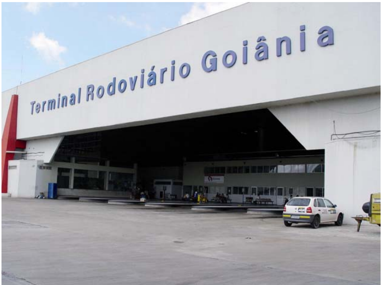
Fig. 91 –Portal Goiânia – Fachada original
