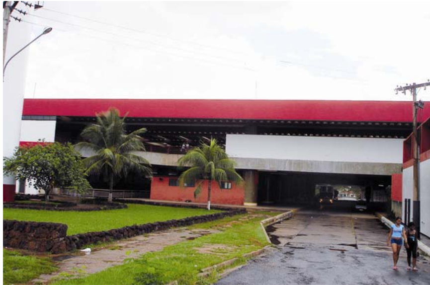
Fig. 83 – Fachada Lateral (Mirante) Portal Cuiabá
