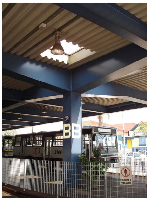
Fig.: 55 – Anexo – Terminal de Integração do Transporte Coletivo
