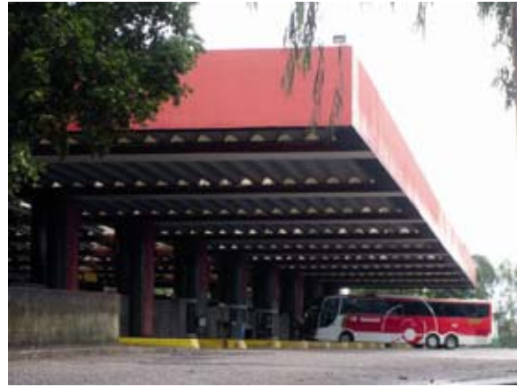
Fig. 87 – Portal Cuiabá – Balanço de 15m
