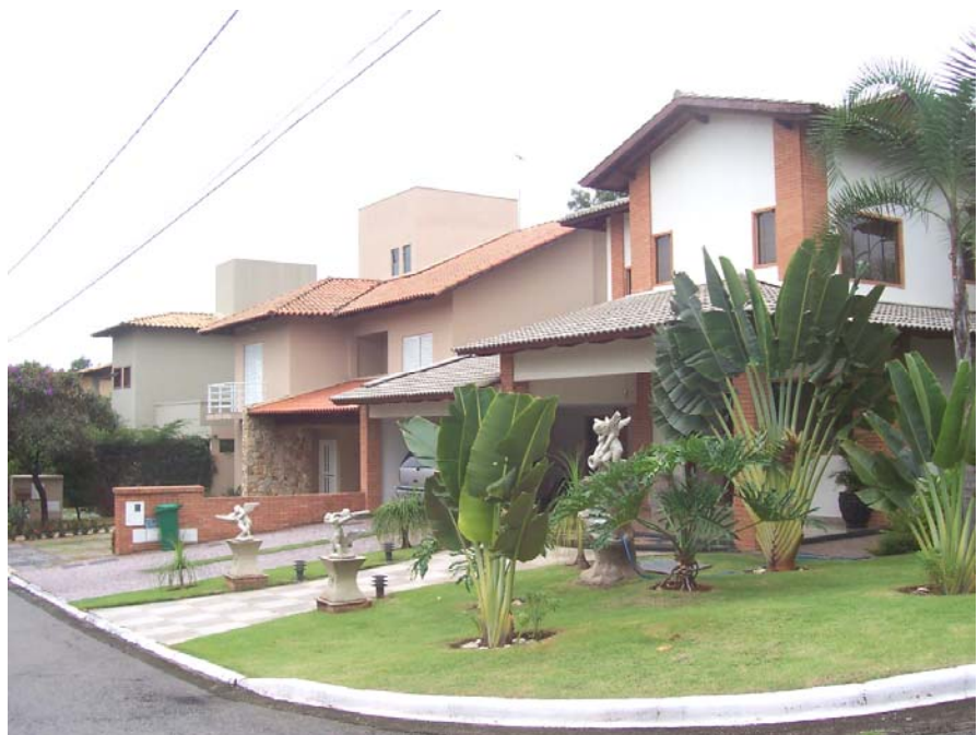
Figura 33 Casa situada em lote de esquina, no Jardins Viena Fonte: Autor
