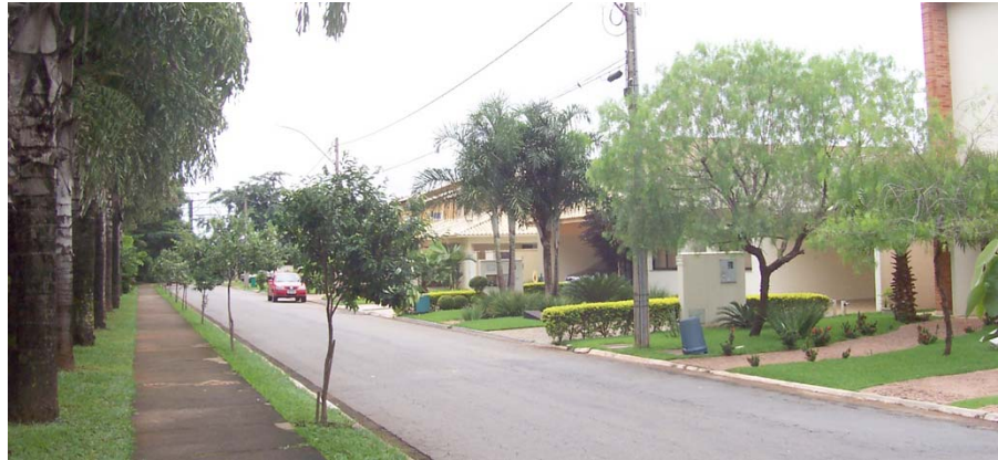
Figura nº 43 Calçadas nas áreas comuns e falta das mesmas na frente dos lotes, no Jardins Viena Fonte: Autor
