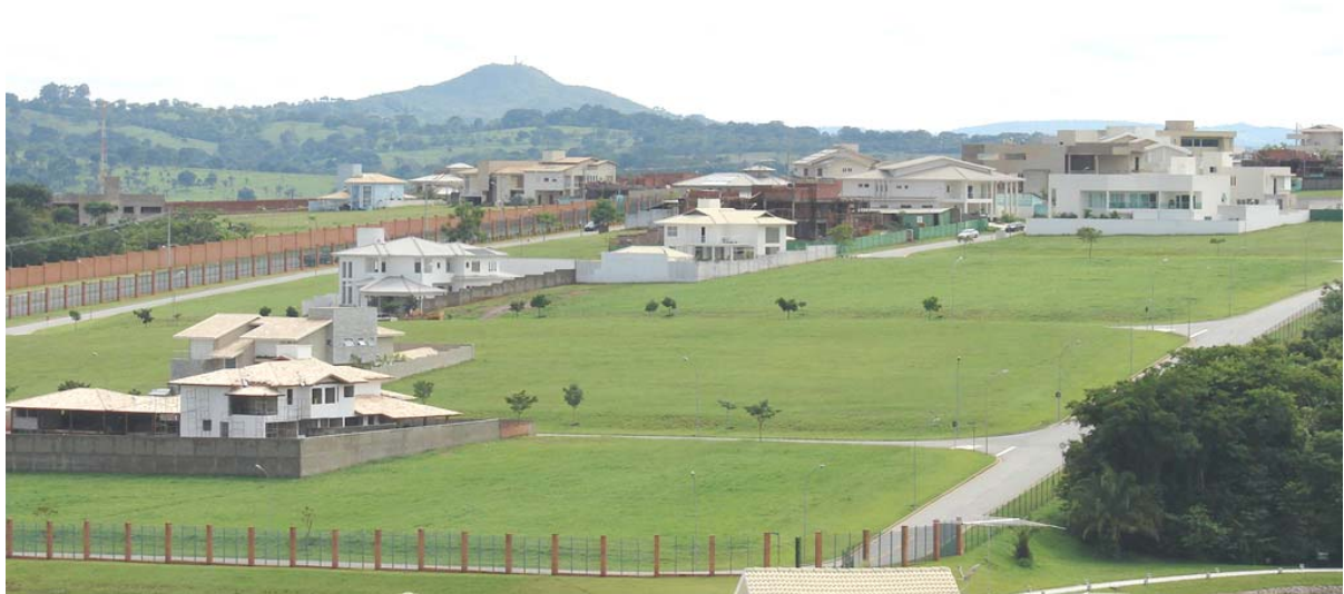
Figura 51 Terraplenagem executada no Alphaville Flamboyant, Residencial Cruzeiro. Fonte: Autor
