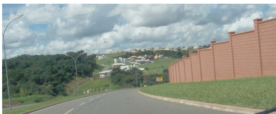
Figura 46 Via de deslocamento local dos residenciais do Alphaville Flamboyant, com muro de fechamento entre eles Fonte: Autor
