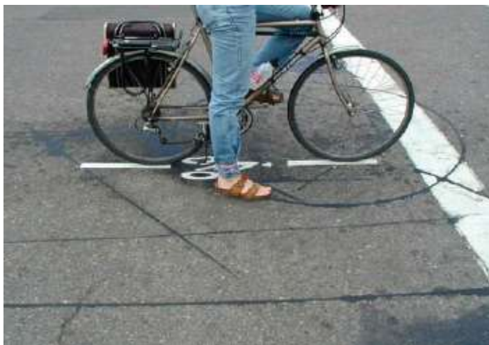
Figura 25 – Indicação de área mais sensível dos detectores de movimento através de sinalização horizontal
