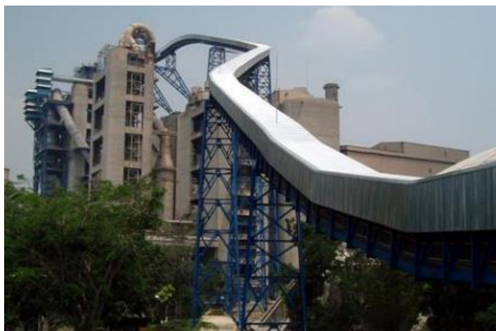
Figura 11 – Transportador de correia na Heidelberg Cement Group, Indonésia
